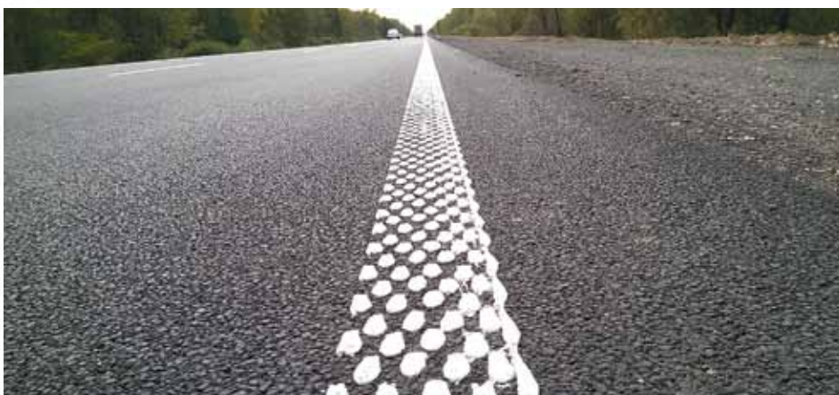
Рис. 4. Пример горизонтальной дорожной разметки со структурной и профильной поверхностью
