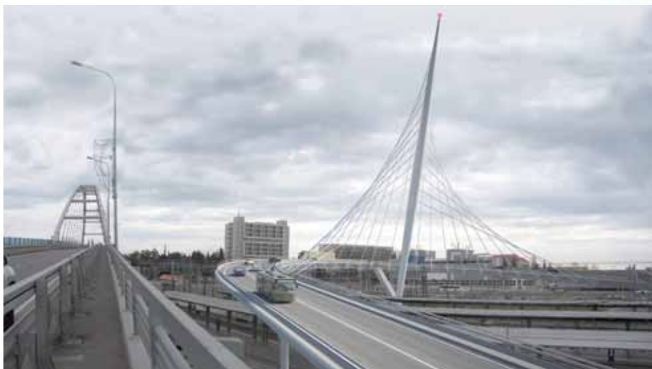
Рис. 4. Мост-эстакада в Адлерском районе г. Сочи
