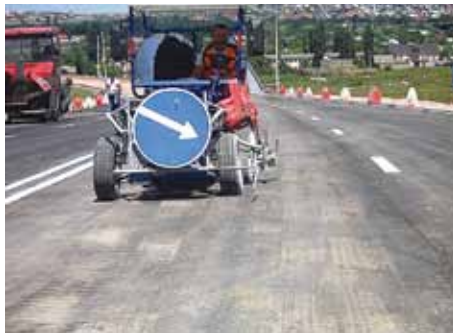
Рис. 3. Участок Симферопольской обьездной автомобильной дороги на участке Мирное – Дубки в период окончания работ
