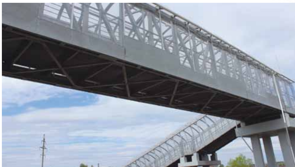
Пешеходный переход на км 12 федеральной трассы Р-193 «Воронеж – Тамбов» вблизи села Бабяково
