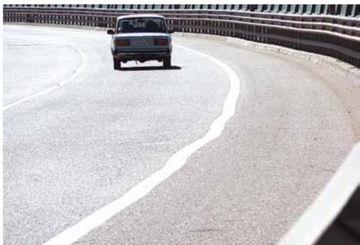
Боковые сдвиговые деформации хорошо определяются по положению разметочной полосы. Мост через реку Бзугу, май 2013 года
