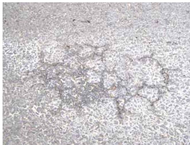
Эстакада ПК 121-131. Локальные скопления трещин на ШМА перед раскрытием
