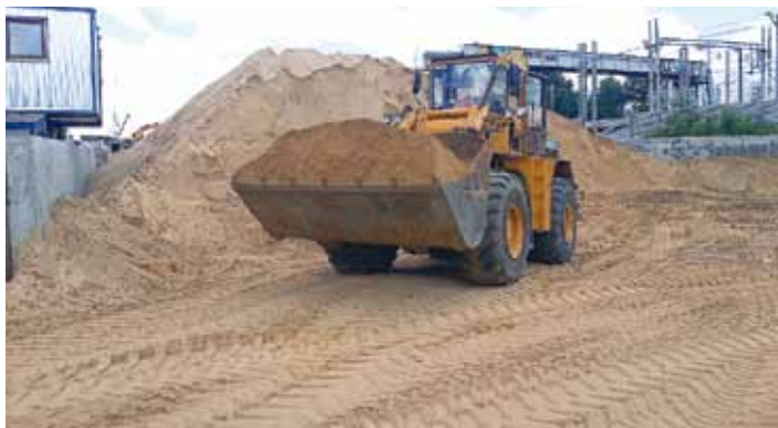
Рис. 18. Подача песка насыпи погрузчиком
