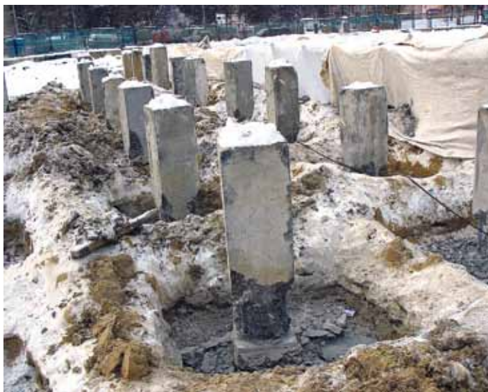
Рис. 11. Забивные сваи 35х35 см для усиления слабого основания насыпи. Некоторые сваи ошибочно забиты под углом к оси створа
