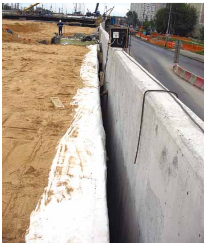
Рис. 24. Обеспечение необходимого зазора между лицевой стенкой и армогрунтовой системой подпорной стены для обеспечения независимой работы армогрунтовой системы и лицевой ж/б стенки
