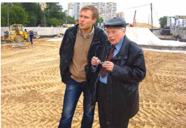
Рис. 16. Инспекционный контроль СМР на участке строительства насыпи. Зав. лаб. металлических мостов В.О. Иванов и вед. науч. сотр. НИЦ «Мосты» А.Д. Соколов
