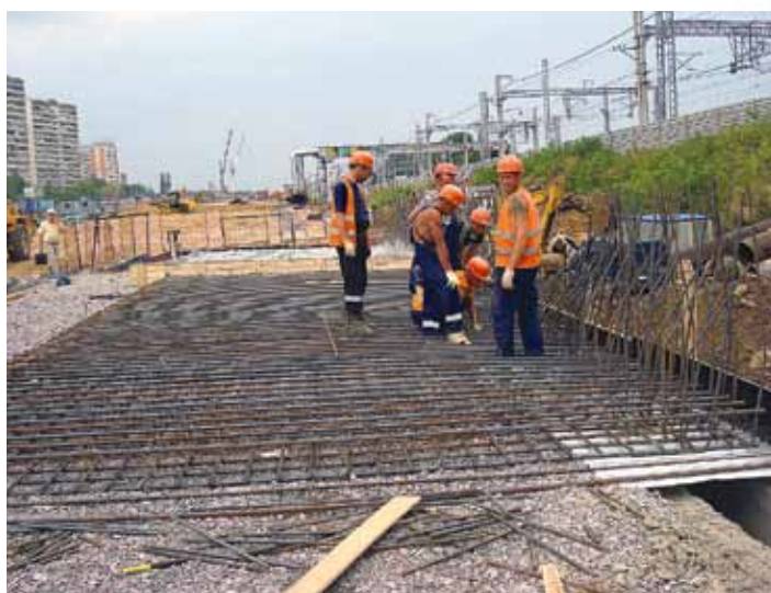
Рис. 32. Монтаж арматурных каркасов плит опирания парапетного ограждения
