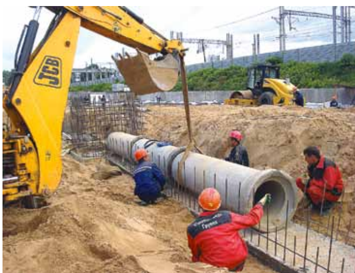
Рис. 31. Укладка труб системы ливневой канализации
