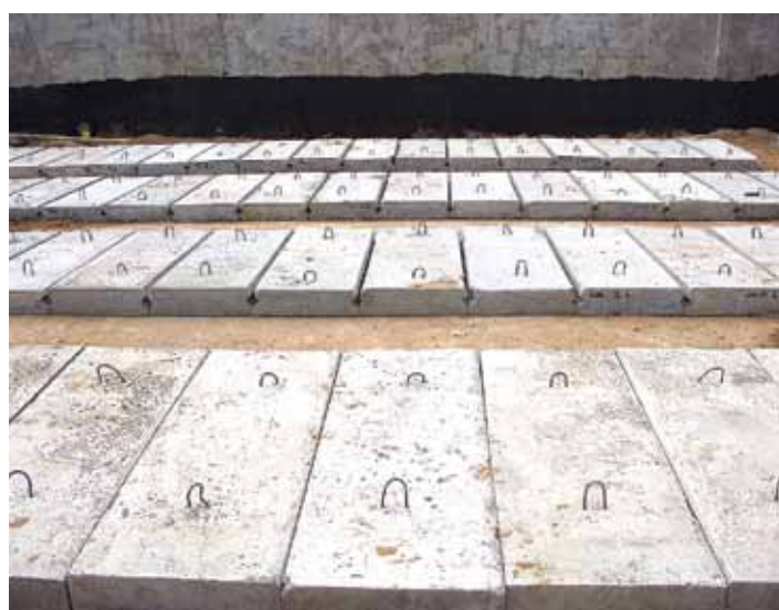
Рис. 29. Между балками-ростверками промежутки перекрыты ж/б плитами
