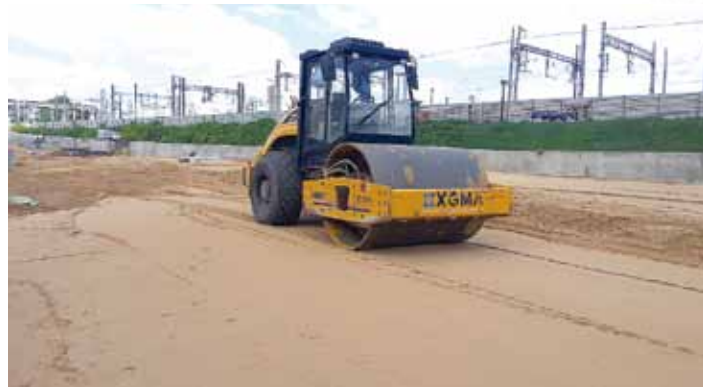
Рис. 19. Уплотнение песка виброкатком до коэффициента уплотнения K_{упл} \geq 0,98 по кривой стандартного уплотнения
