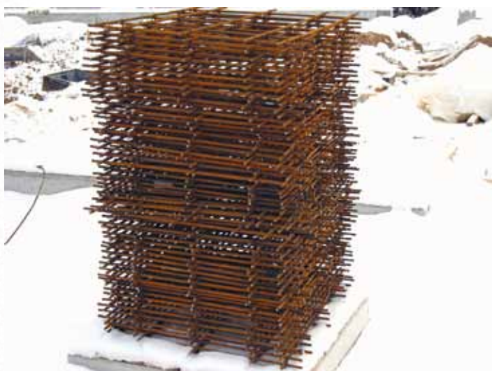
Рис. 12. Арматурные каркасы оголовников забивных свай
