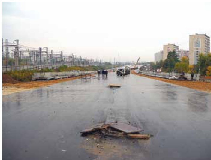
Рис. 34. Уложено асфальтобетонное покрытие. Насыпь подхода готова к открытию движения
