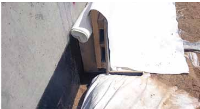
Рис. 22. Установка опалубочного щита с зазором до лицевой стенки 22 см
