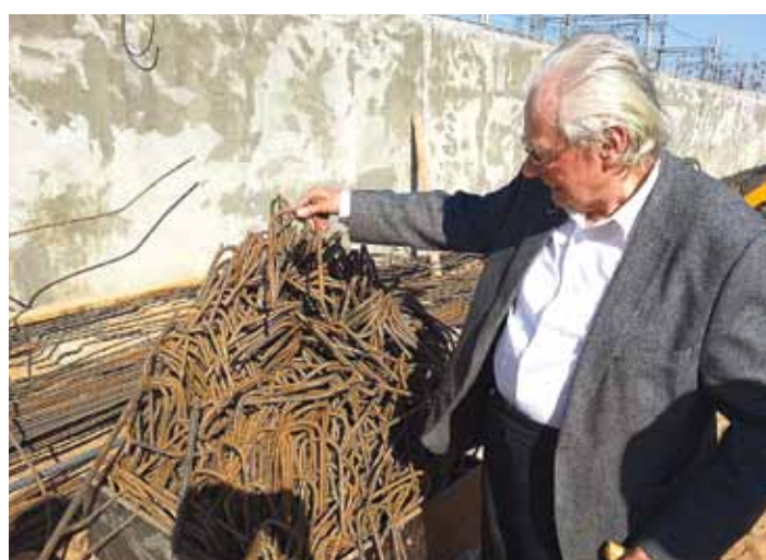
Рис. 26. П-образные шпильки из арматуры Ø10 мм с заточенными концами для крепления геосинтетики
