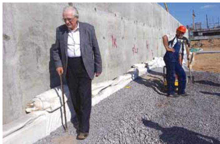
Рис. 21. Щебеночная призма отсыпается слоями из двух фракций гранитного щебня с уплотнением методом заклинки
