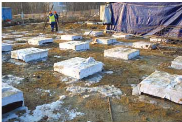
Рис. 14. Оклеенные дорнитом оголовники свай
