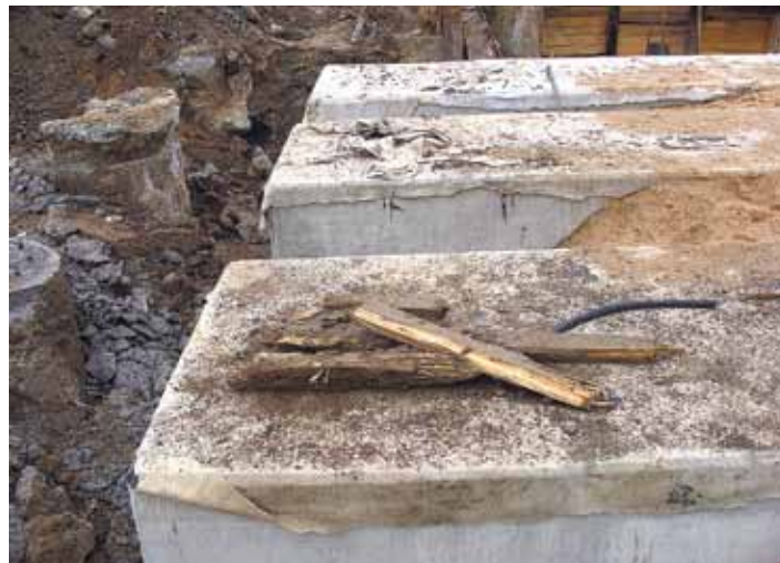
Рис. 28. Балки-ростверки перекрытия траншеи коммуникации
