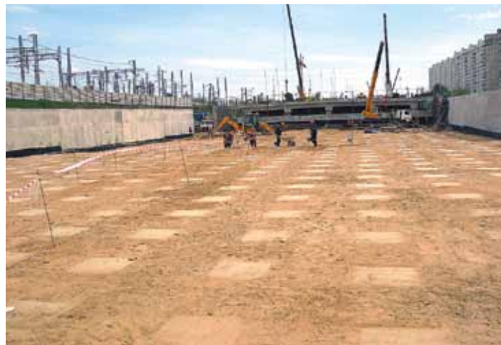
Рис. 17. Участок насыпи, усиленный забивными сваями с оголовниками под расстилку геосинтетики
