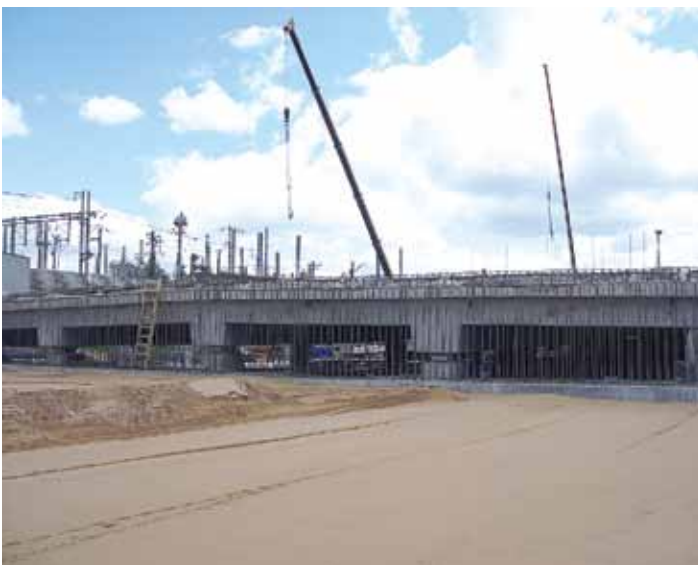
Рис. 10. Участок насыпи подхода к эстакаде № 1 транспортной развязки у Фестивальной улицы
