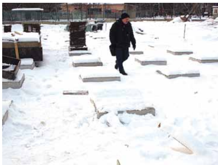
Рис. 13. Забетонированные в зимнее время оголовники забивных свай
