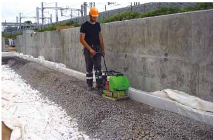
Рис. 20. Послойное уплотнение щебеночной призмы виброплитой
