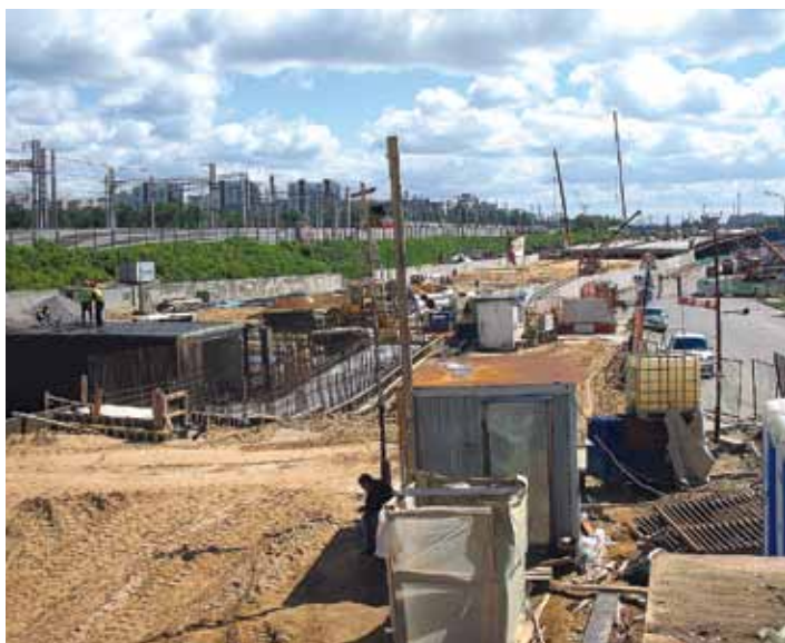
Рис. 9. Панорама строительства насыпи подхода к эстакаде № 1 транспортной развязки у Фестивальной улицы
