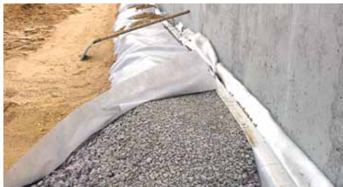
Рис. 23. Щебеночная призма отделяется от песка разделительным материалом Турар CF 40
