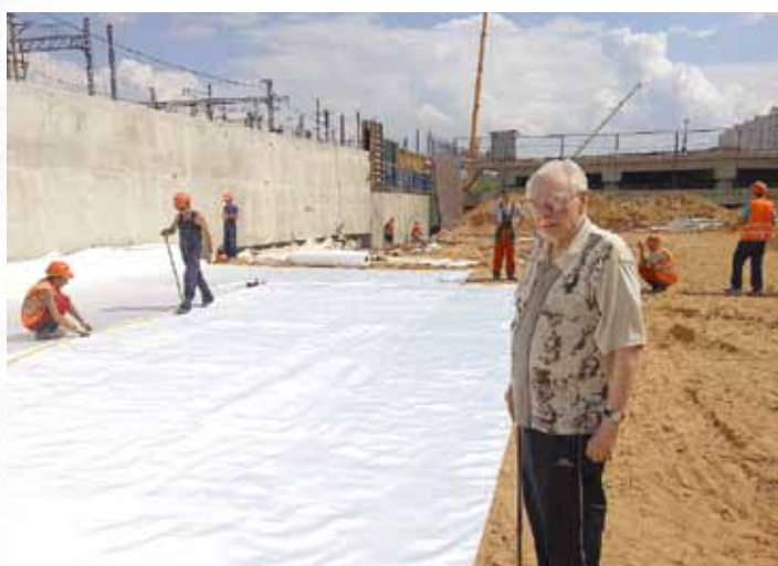
Рис. 25. Укладка поперечного слоя геосинтетики Армогат 600/100. Длина 50 м подобрана расчетом для безотходного использования рулона
