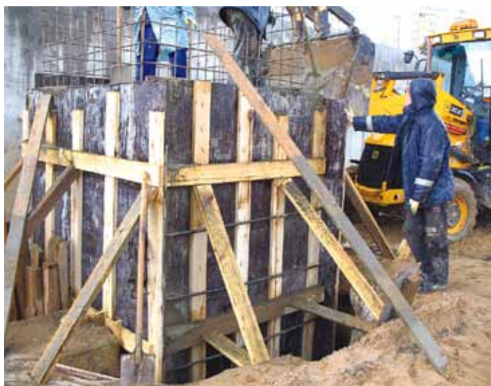
Рис. 30. Бетонирование колодца ливневой канализации К-95
