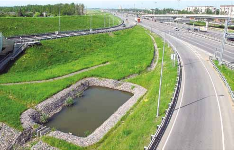
Рис. 6. КАД в районе развязки с Дачным проспектом. На переднем плане ГБП. Слева сверху шумозащитный вал, сложенный из излишних грунтов, образовавшихся при строительстве, и защищающий территорию нескольких садоводств
