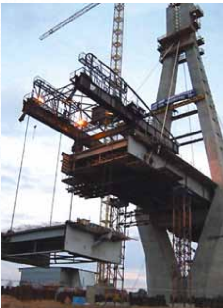
Рис. 3. Монтаж блока пролетного строения. Мост в Муроме
