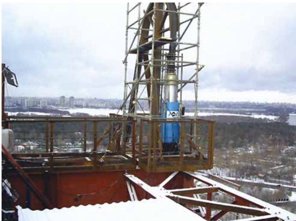
Рис. 2. Подъемный домкрат SLU-330/550F, установленный на верху арочного пилона. Живописный мост в Москве
