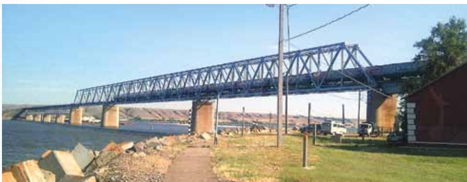
Рис. 7. Железнодорожный мост через Дон в Волгоградской области
