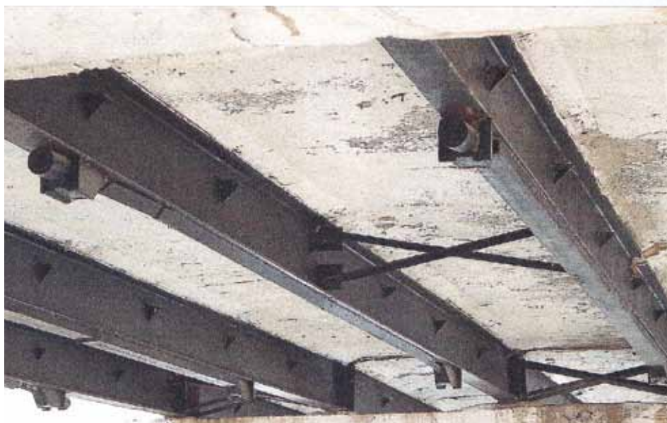
Вид снизу на металлические балки с преднапряженной стеклопластиковой арматурой
