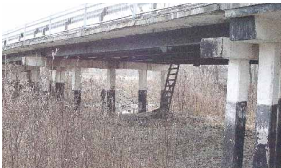
Сталежелезобетонное экспериментальное пролетное строение моста. На нижнем поясе крайней балки – упоры стеклопластиковой арматуры
