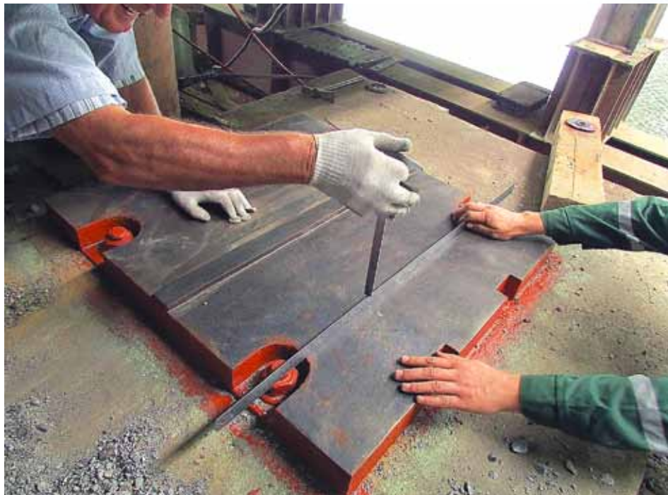
Рис. 12. Контроль качества отремонтированной поверхности качения нижней опорной плиты опорной части на опоре № 5
