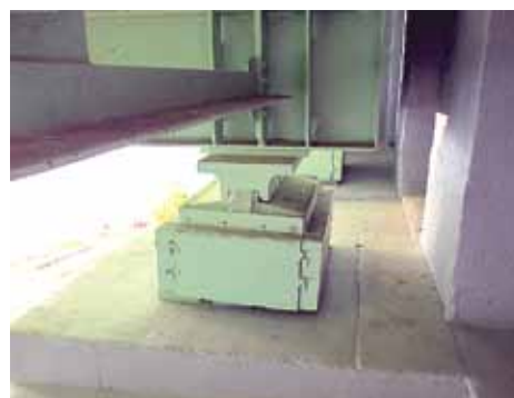
Рис. 16. Подвижная опорная часть с двумя срезными катками на опоре № 1
