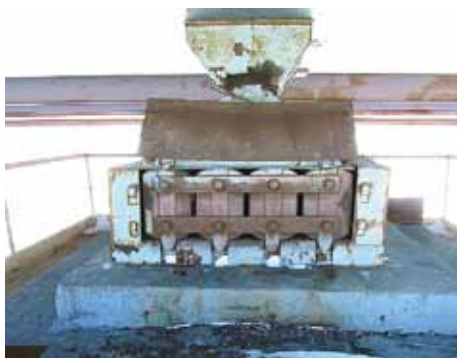
Рис. 3. Подвижная опорная часть с четырьмя срезными катками на опоре № 2
