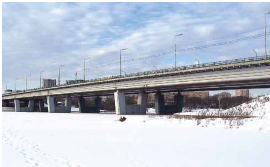
Рис. 1. Общий вид моста через реку Москву со стороны г. Москвы
