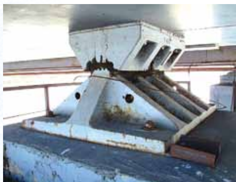
Рис. 2. Неподвижная опорная часть на опоре № 3
