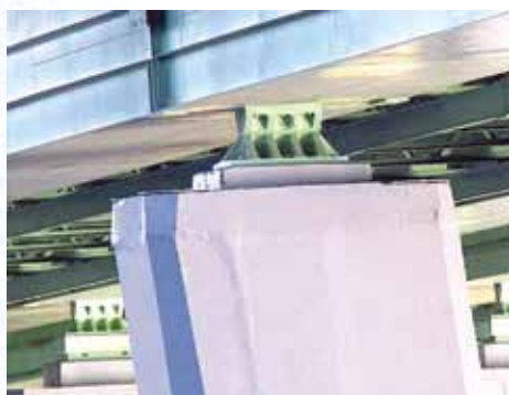
Рис. 14. Неподвижная опорная часть на опоре № 3
