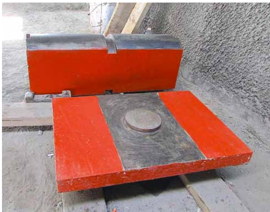
Рис. 13. Каток и верхний балансир после ремонта перед сборкой опорной части
