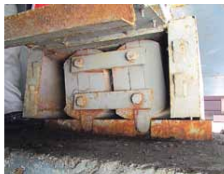
Рис. 4. Подвижная опорная часть с двумя срезными катками на опоре № 1
