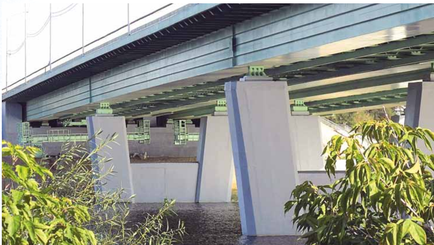
Рис. 17. Общий вид моста после реконструкции
