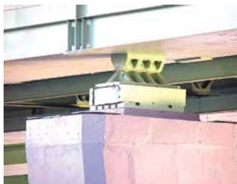
Рис. 15. Подвижная опорная часть с четырьмя срезными катками на опоре № 2
