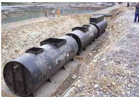
Строительство очистных сооружений на автодороге Адлер – «Альпика-Сервис»
