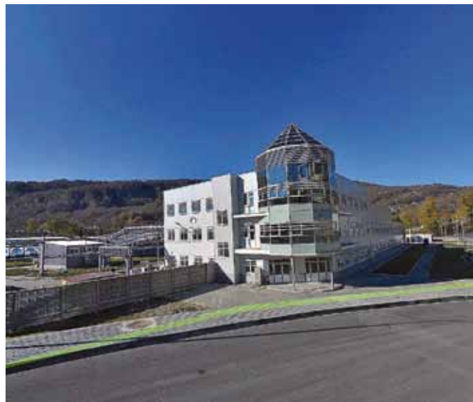
Тоннельная инженерно-техническая база в пос. Ахштырь
