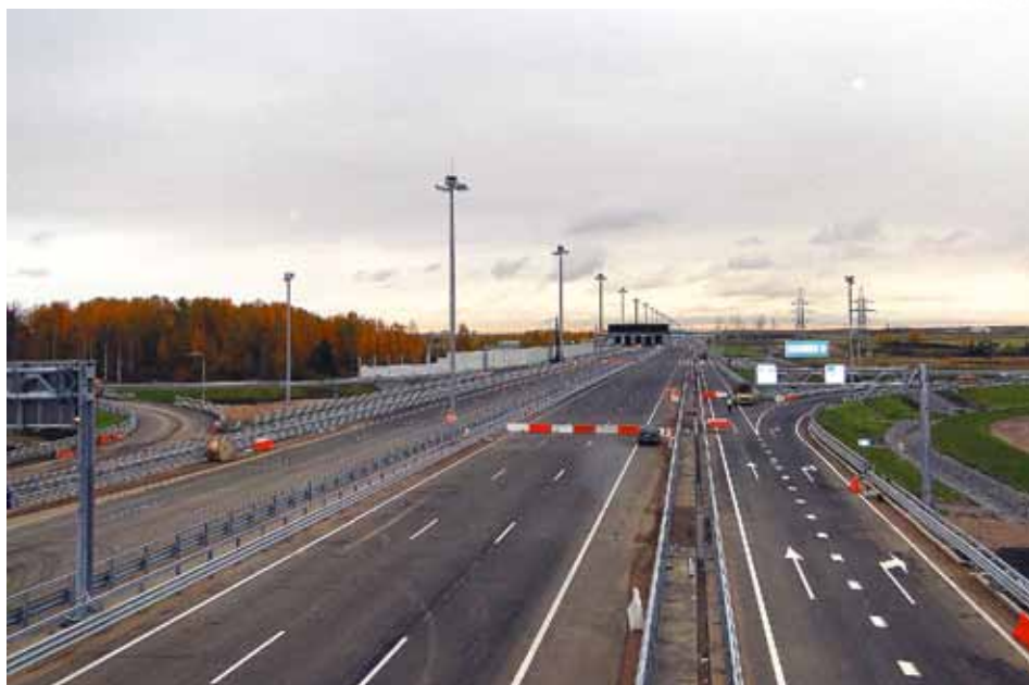
Строительство транспортной развязки на КАД (Стрельна – Пески)
