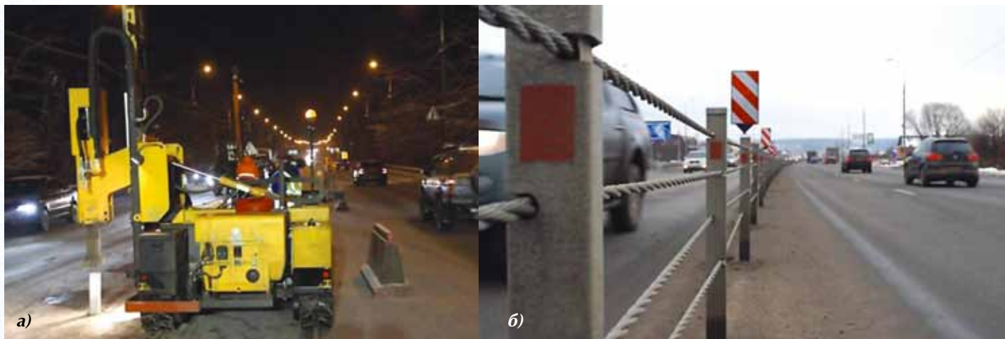
Рис. 9. Устройство тросовых ограждений на дороге А-104 «Москва – Дубна», работы проводит ООО «НПО «Медиана»: а) забивка гильз под стойки; б) ограждение в эксплуатации
