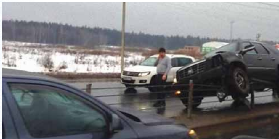
Рис. 10. Фото наезда джипа на тросовое ограждение на дороге А-104 «Дмитров – Дубна»
