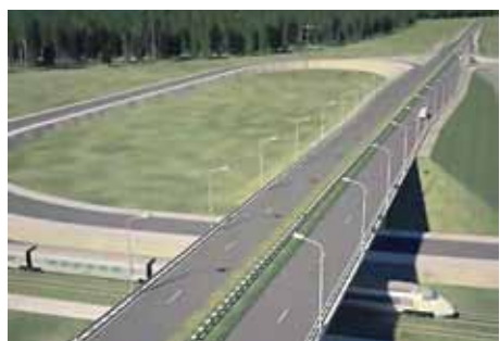
Рис. 5. Двухуровневая транспортная развязка по типу «клеверный лист» на участке ВСМ
