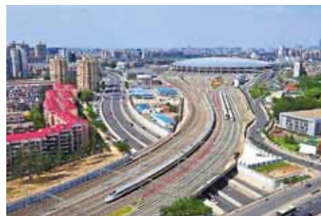
Рис. 6. Двухуровневая транспортная развязка по типу «прокол» на участке ВСМ
