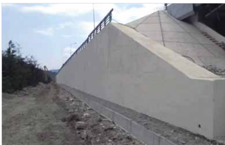
Рис. 8. Общий вид низовой подпорной стенки
