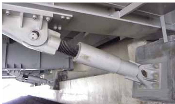
Рис. 6. Демпферное устройство
