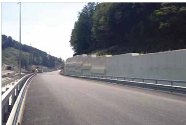
Рис. 10. Общий вид верхней подпорной стенки
