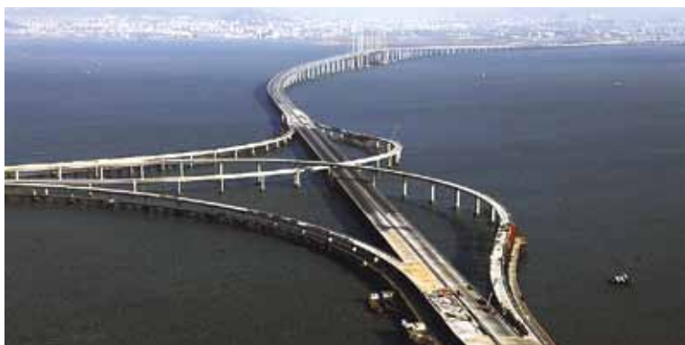
Китай, мост Циндао Хайван, длина моста 42,5 км
