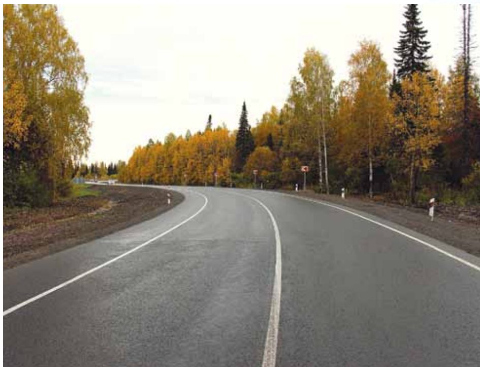
Отремонтированный участок М-53 «Байкал» в Кемеровской области. Октябрь 2013 года
