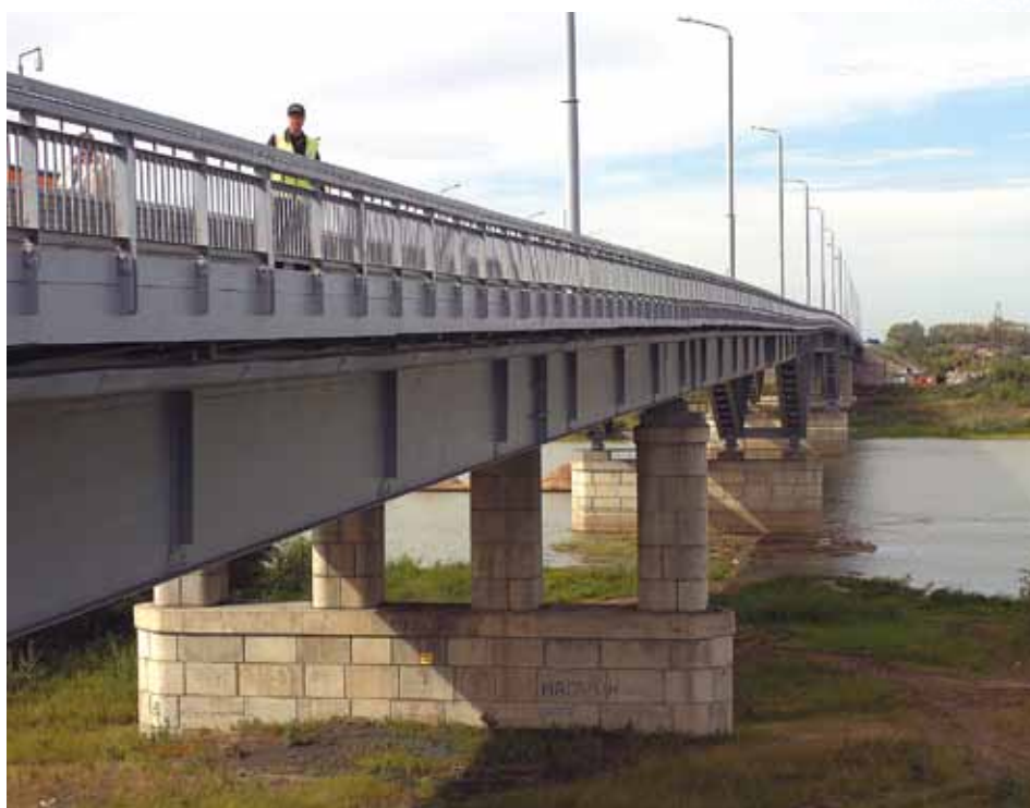
Мост на Южном обходе Омска после ремонта. Сентябрь 2013 года
