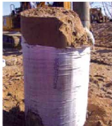
Песчаные сваи в геосинтетической оболочке Ringtrac
