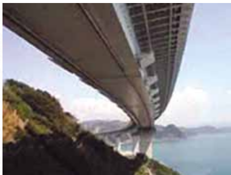
Рис. 7. Вид аэродинамических обтекателей, установленных на виадуке Tozaki
