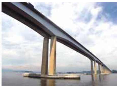
Рис. 1. Мост Rio-Niteroi. Вид на центральные пролеты
