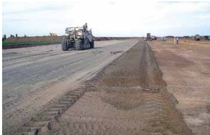
Фото 2. Строительство основания дорожной одежды взлетной полосы из суглинка тяжелого пылеватого, укрепленного цементом
