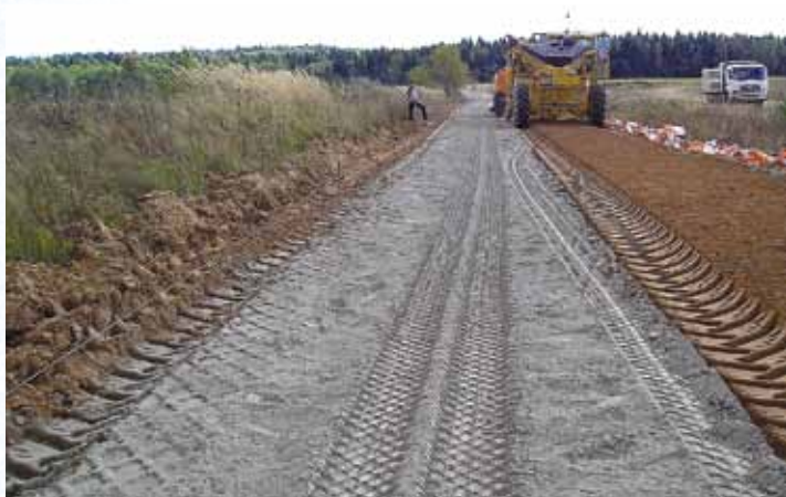
Фото 1. Размельчение суглинка тяжелого песчанистого и обработка его цементом с помощью ресайклера
