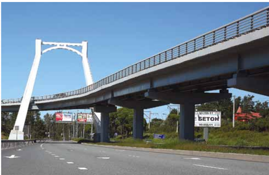
Развязка КАД с Приморским шоссе у станции «Горская»
