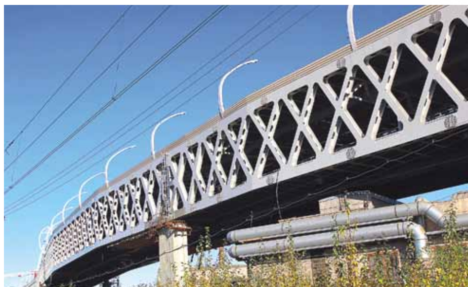
Двухъярусные фермы в составе II очереди ЗСД
