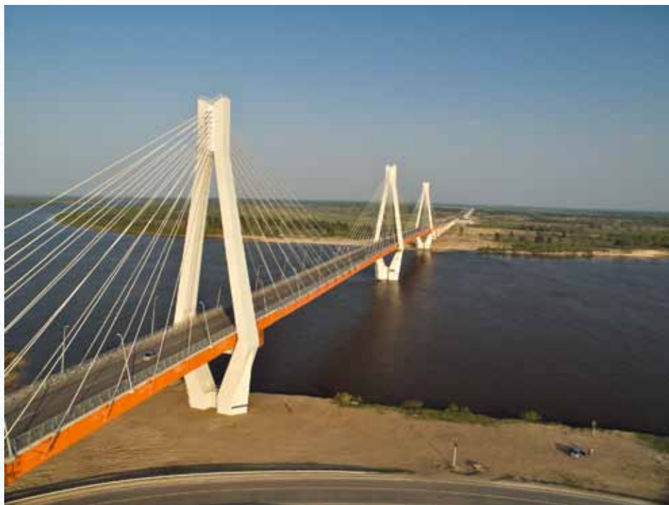
Г место. Мост через реку Оку на обходе г. Муром
