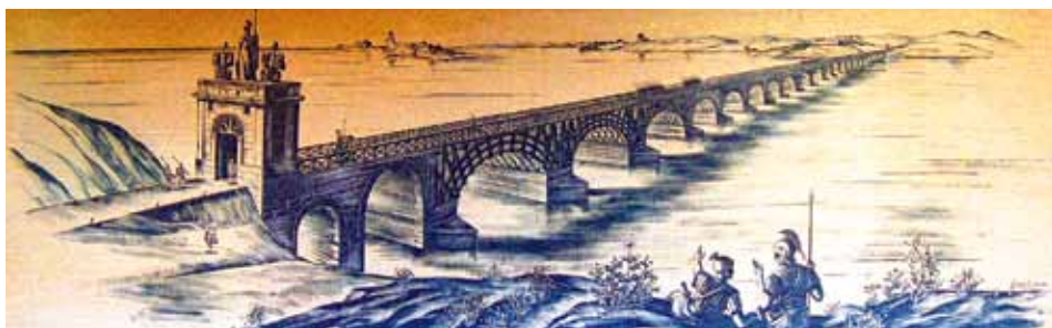
Рис. 2. Мост Траяна через Дунай
