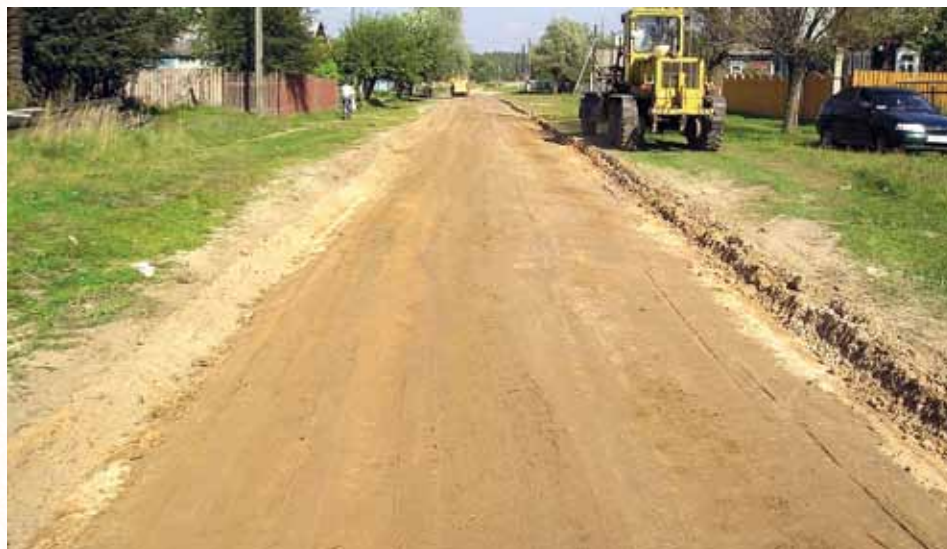
Фото 1. Слой стабилизированного грунта
