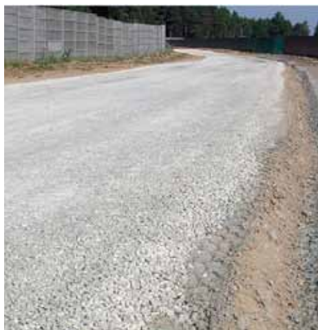
Фото 2. Слой износа из щебня на стабилизированном грунте
