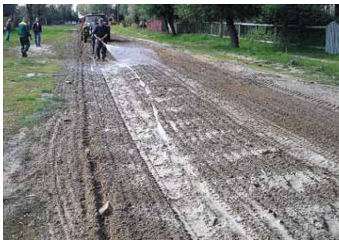
Фото 3–4. Способы внесения в грунт раствора стабилизатора
