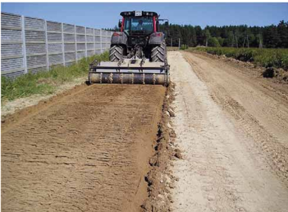
Фото 6. Перемешивание смеси грунта со стабилизатором
