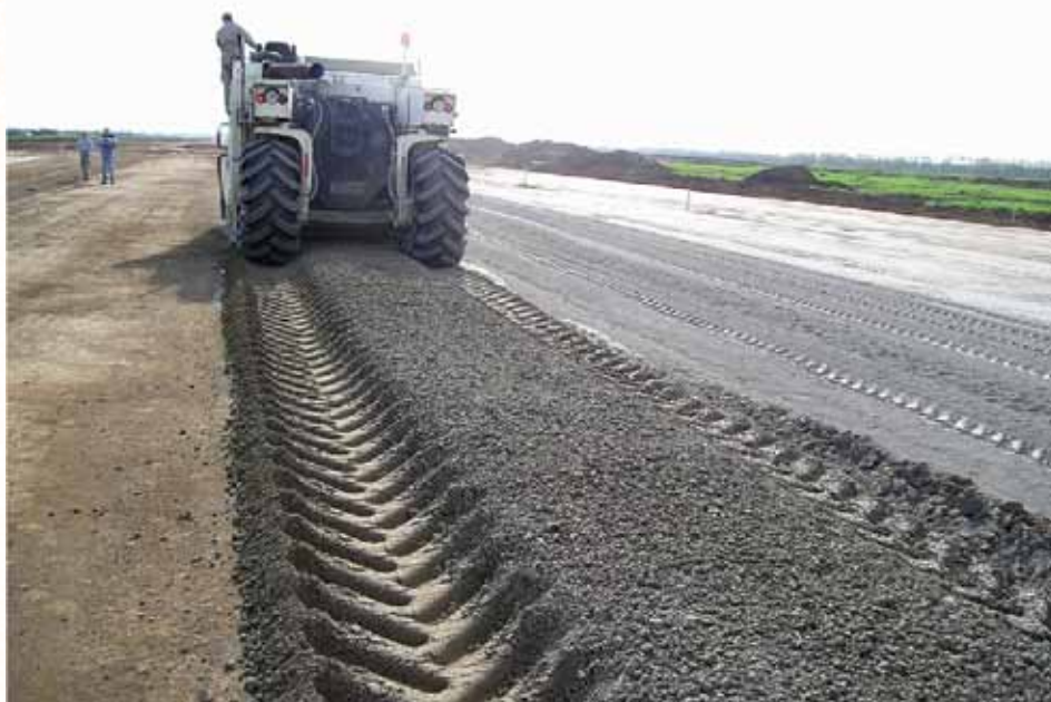
Фото 5. Перемешивание смеси грунта с цементом и стабилизатором
