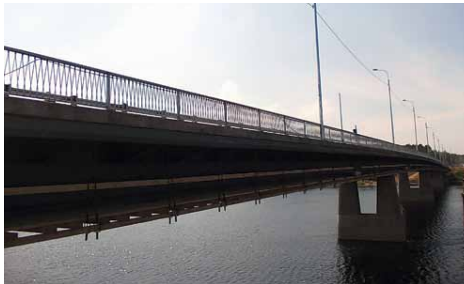
Мост через реку Паша на автодороге М-18 «Кола»
