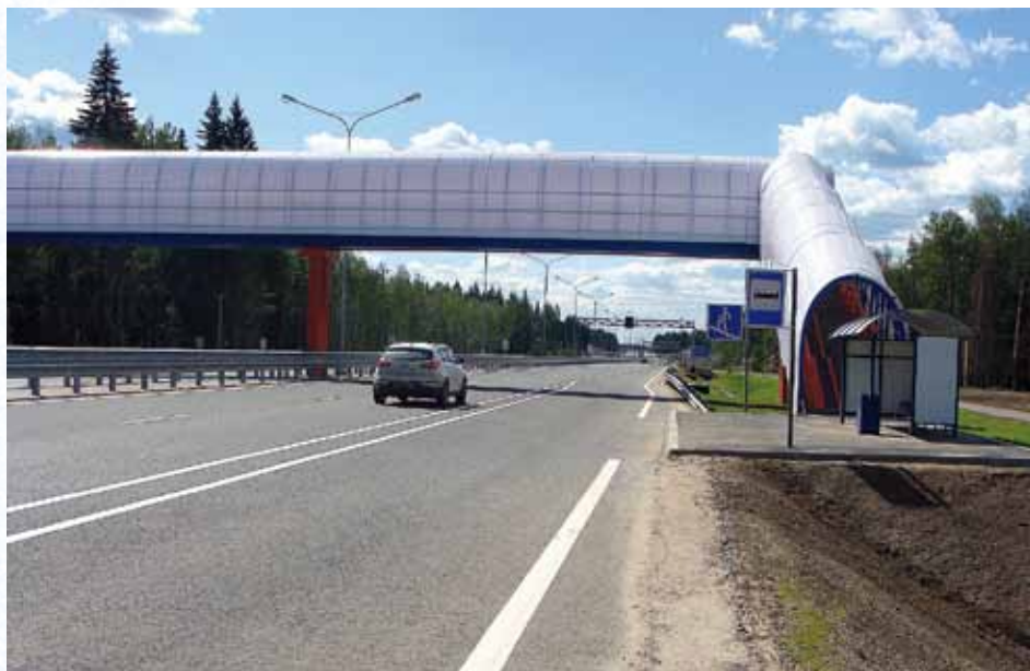
Автодорога А-121 «Сортавала» (вторая очередь)
