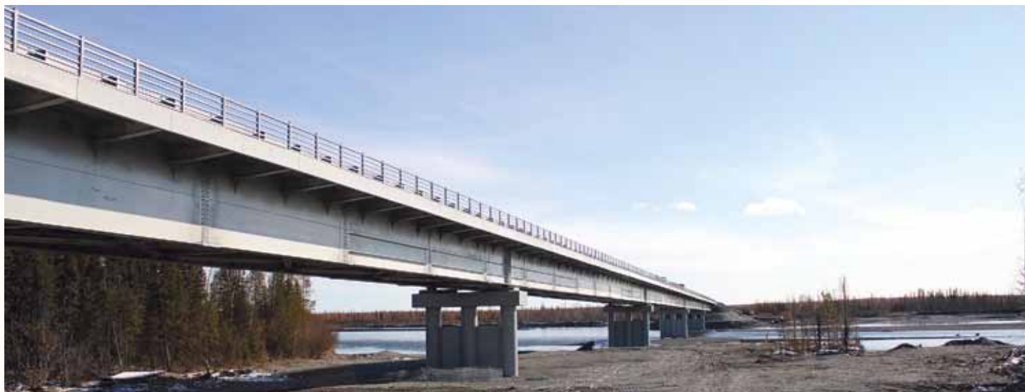
Мостовой переход через р. Восточная Хандыга
