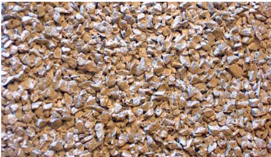
Рис 1. Поверхность нижнего слоя двуслойного дорожного покрытия из нового дренирующего бетона
