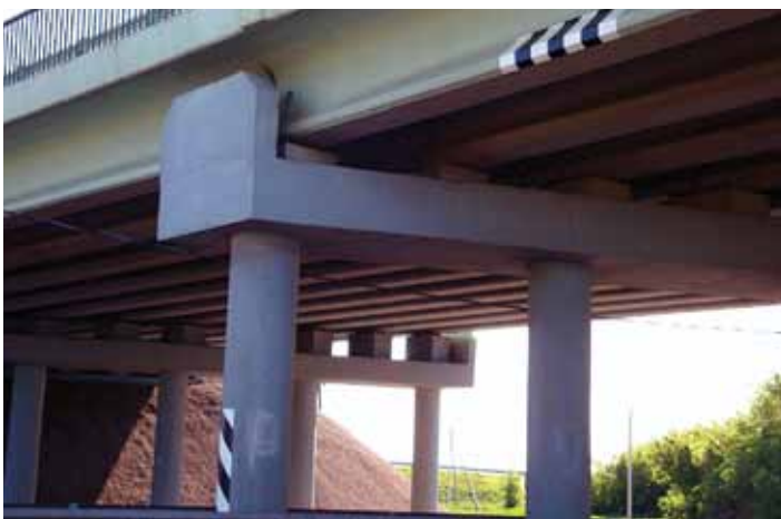
Цельные монолитные бетонные конструкции опор путепровода с исключением швов омоноличивания. Применение: мосты и путепроводы автодороги М-4 «Дон»
