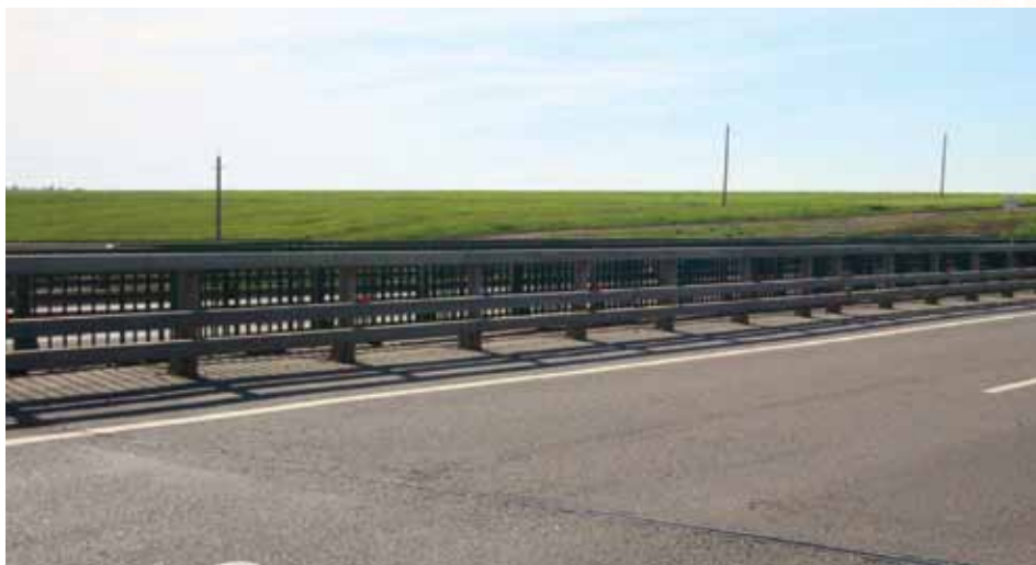
Усиленное барьерное ограждение. Применение: мосты и путепроводы на автодороге М-4 «Дон»
