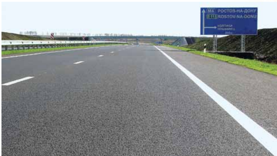
Асфальтобетонное покрытие на автодороге М-4 «Дон», выполненное с применением широкозахватных асфальтоукладчиков и перегружателей типа «Шаттл-Багги» Roadtec SB-2500D (США). Технология исключает продольные швы по ширине полосы
