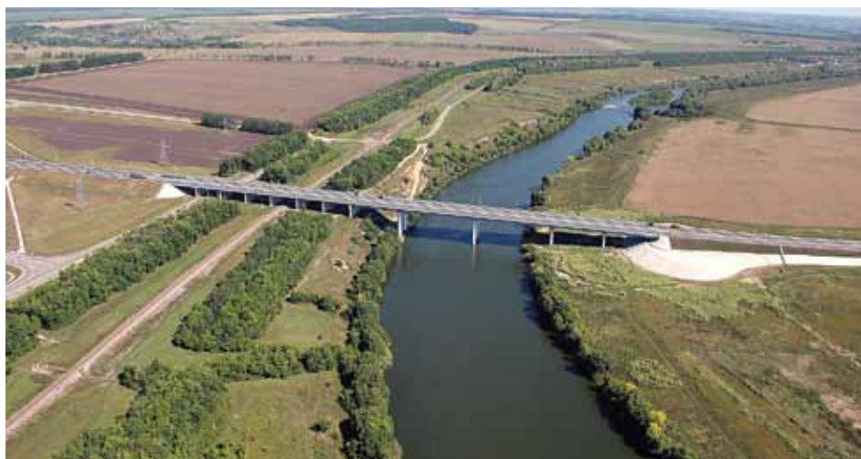
Мостовой переход на обходе Ельца (автодорога М-4 «Дон»)
