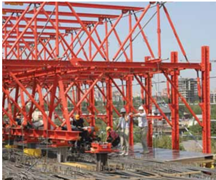
Передвижной агрегат для бетонирования плиты проезда сталежелезобетонных мостовых пролетных строений. Применение: автодорога М-4 «Дон»
