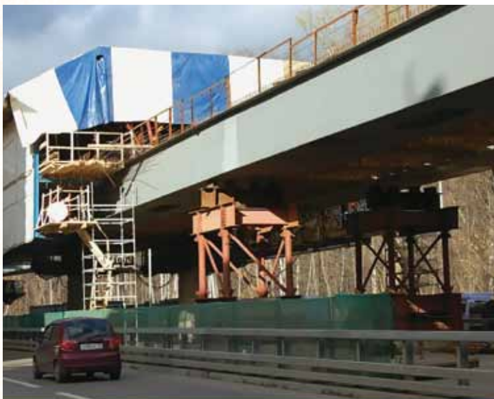
Передвижной агрегат для бетонирования плиты проезда сталежелезобетонных мостовых пролетных строений. Применение: автодорога М-4 «Дон»
