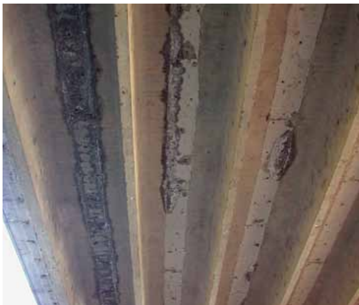
Рис. 2. Начальная степень деградации типового железобетонного пролетного строения моста через 10 лет эксплуатации: наибольшая площадь протечек отмечается в зоне крайних балок
