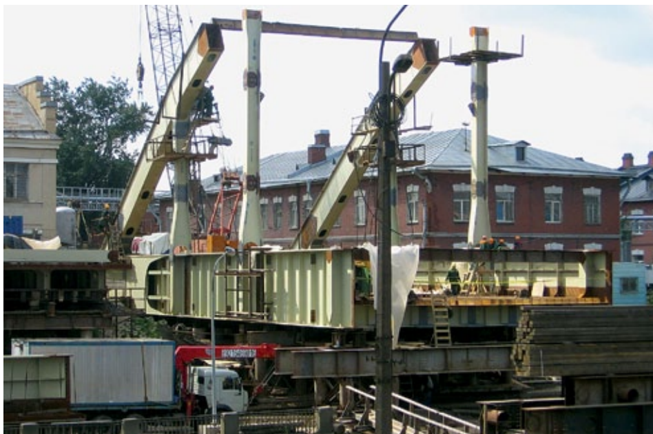
Рис. 6. Ведение работ в условиях плотной городской застройки
