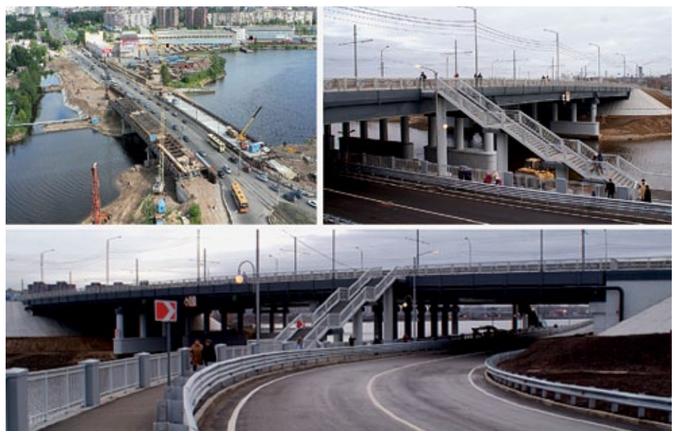
Рис. 5. Реконструкция моста через реку Ягорбу в Череповце
