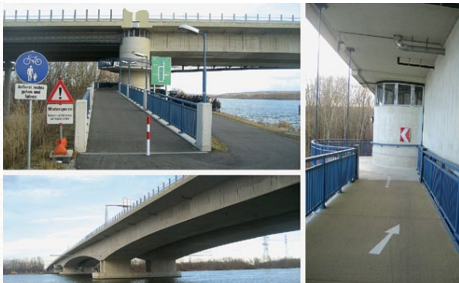
Рис. 1. Пример реализации инфраструктурного подхода на мосту через Дунай в Австрии
