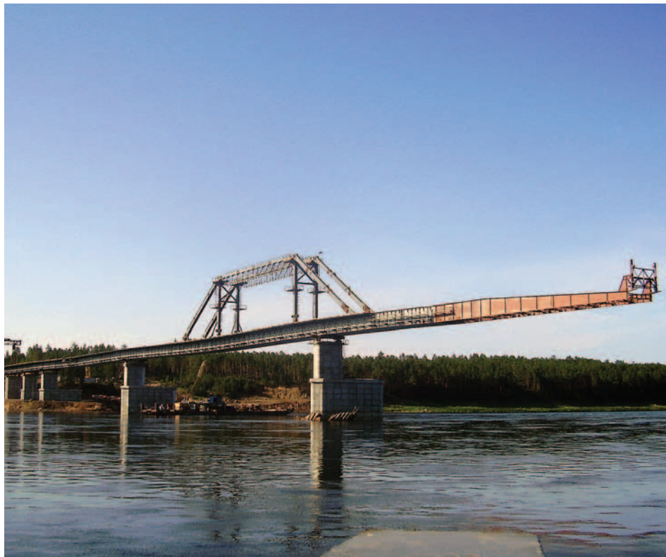
Рис. 2. Монтаж пролетного строения с левого берега
