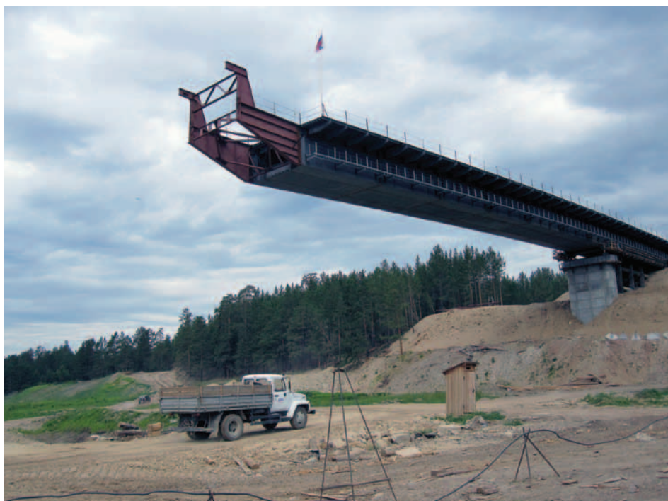
Рис. 3. Монтаж пролетного строения с правого берега
