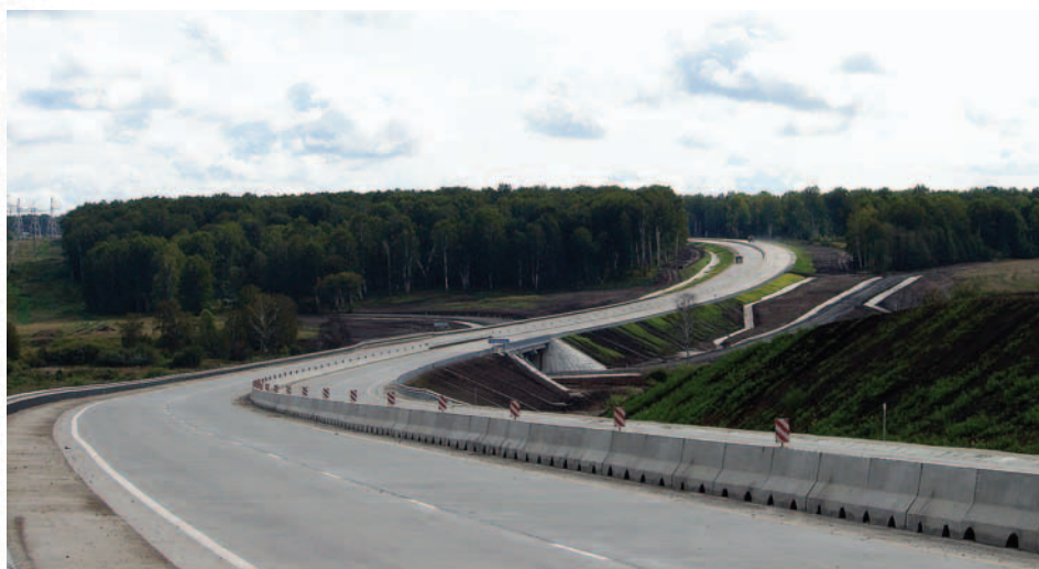
Участок ПКМ северного обхода Новосибирска
