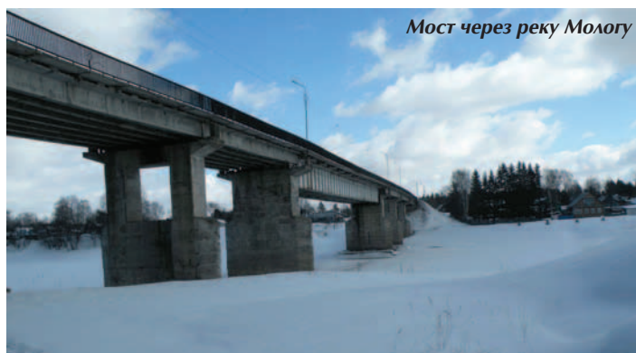
Испытание моста через реку Вырку
