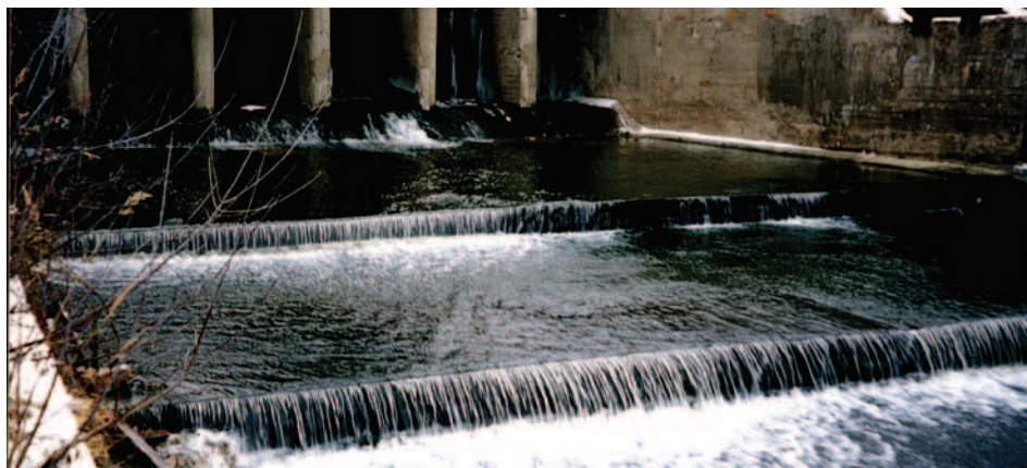
Фото 2. Обследование фундамента на ступенях на плотине Людиновского гидроузла
