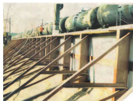
Фото 3. Изготовление буронабивных железобетонных свай РИТ в структурно-неустойчивых грунтах без перерывов в движении поездов
