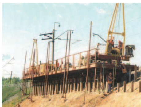
Фото 2. Укрепление грунтового массива и его основания железобетонными буронабивными сваями РИТ, изготавливаемыми МРИК
