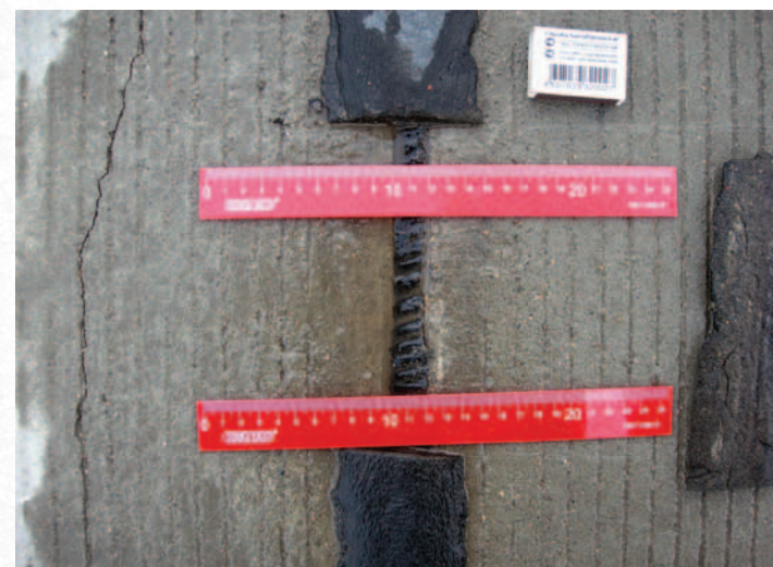
Рис. 1. Перрон АВК-1 (16.12.07) + 4С. Состояние швов теплового расширения, фактическая величина швов в пределах 10–12 мм. Наблюдается значительное выдавливание герметика с сопутствующим образованием продольных трещин второго типа вдоль швов
