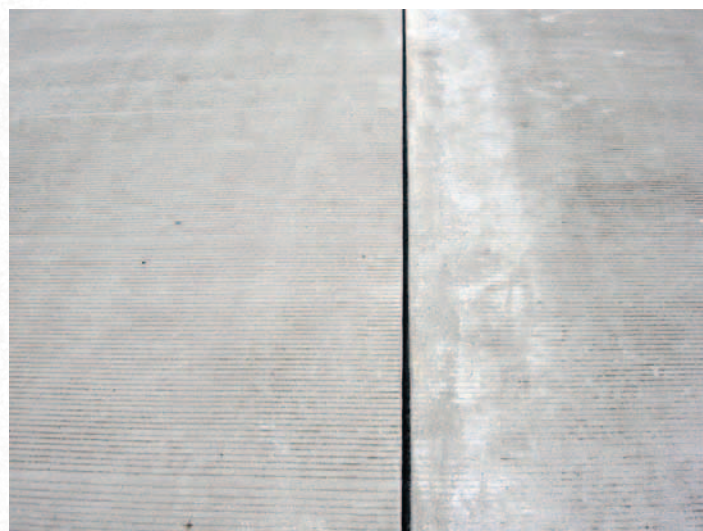
Рис. 5. Стык полос на ВИП-перроне. Слева полоса 6р, уложенная между готовыми полосами 7р и 5р. Справа полоса 5р, уложенная с открытыми торцами
