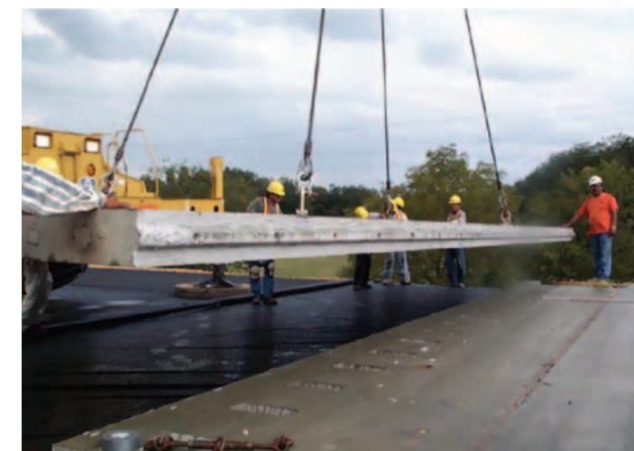
Рис. 7. Подача бетонной плиты сборного типа на дорожное земляное полотно с подсыпкой дренирующего песчаного слоя, укрытого полиэтиленовой пленкой. По торцу плиты видны отверстия для ввода стягивающих стальных канатов
