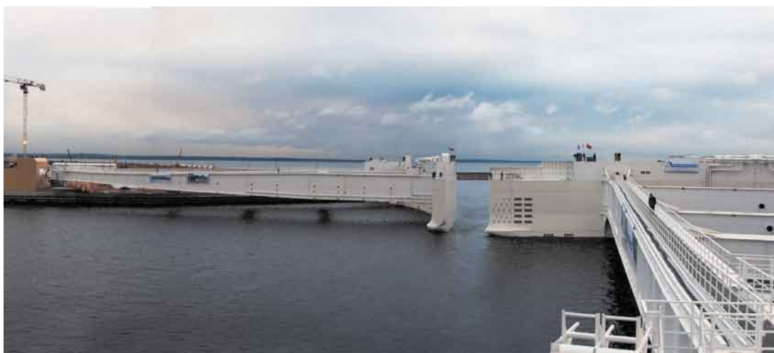
Комплекс защитных сооружений Петербурга от наводнений
