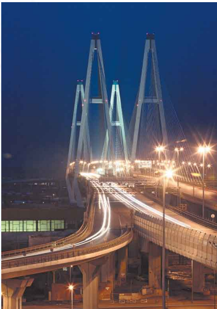
Большой Обуховский мост
