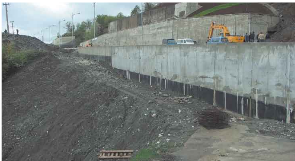
Рис. 2. Противооползневые мероприятия (нижняя подпорная стенка) на участке ПК 88–89
