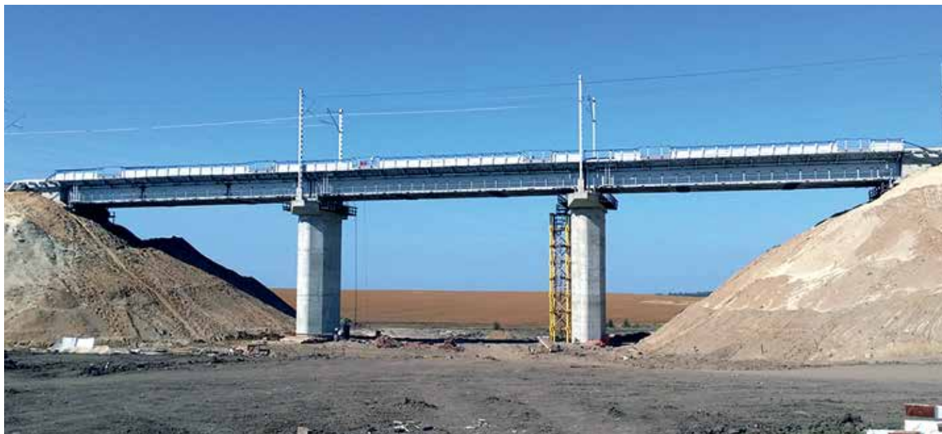
Рис. 1. Общий вид железнодорожного путепровода
