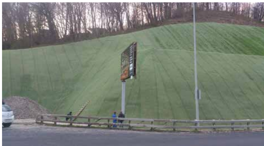
Процесс монтажа геомата МакМат R на а/д А-147 Джубга-Сочи
