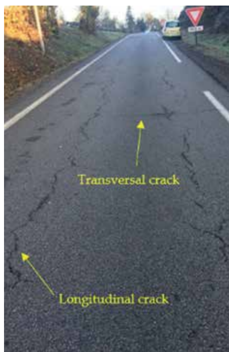
Рис. 2. Усталостные трещины при механизме образования сверху-вниз
