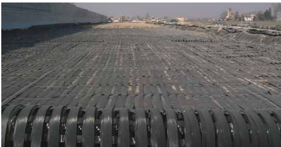
Армирование основания насыпи с использованием высокопрочной георешетки ПараЛинк®
