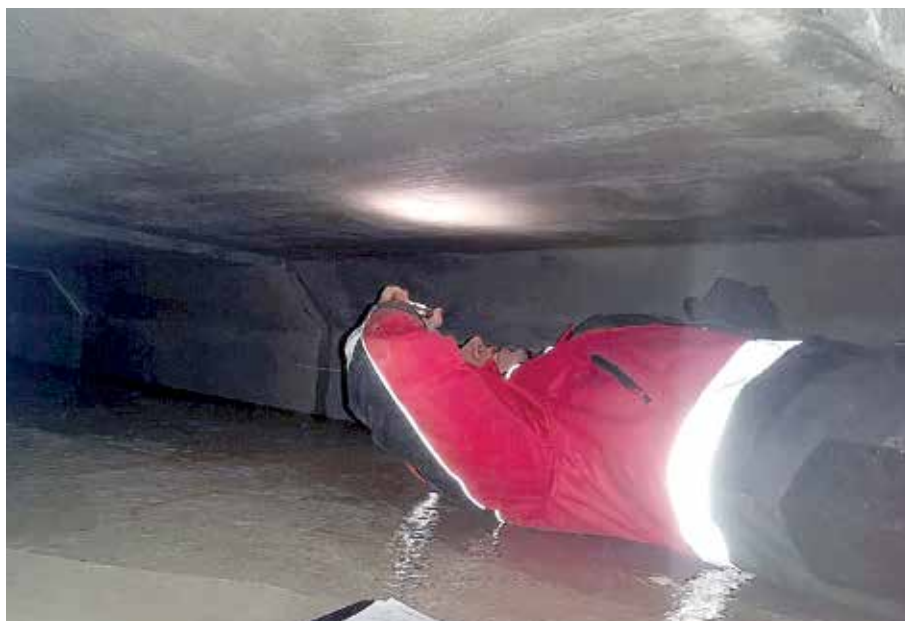
Рис. 6. Габарит трубы по оси автодороги не превышает 0,5 м
