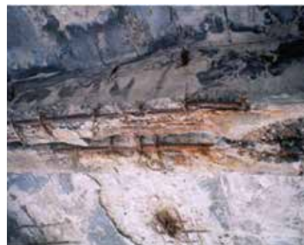
Рис. 1. Коррозия арматуры в месте разрушения защитного слоя
