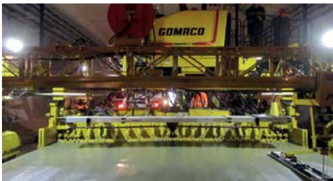
Устройство из цементобетона путевых призм и различных профилей в железнодорожных тоннелях, проезжей части и различных профилей в автодорожных тоннелях с применением универсального бетоноукладчика Commander III в тоннельных комплексах трассы Адлер – горноклиматический курорт «Альпика-Сервис», где впервые в России применена система нивелирования 3D (без струны).
