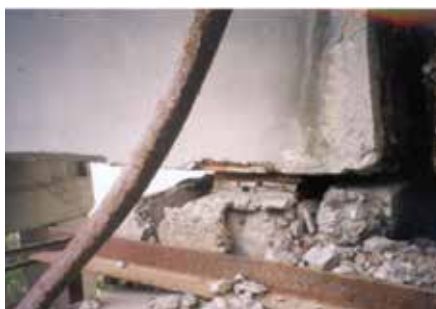
Рис. 2. Разрушение подферменника и опорной части (слева) и защитного слоя ригеля опоры (справа) вследствие систематического увлажнения через негерметичный деформационный шов
