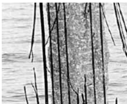
Рис.. 4. Повреждения железобетонных элементов в морской воде
