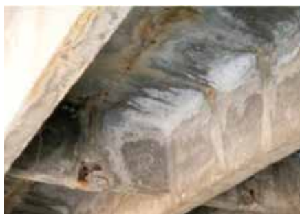
Рис. 3. Повреждения железобетонных пролётных строений в результате коррозии арматуры
