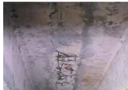
Рис. 3. Повреждения железобетонных пролётных строений в результате коррозии арматуры
