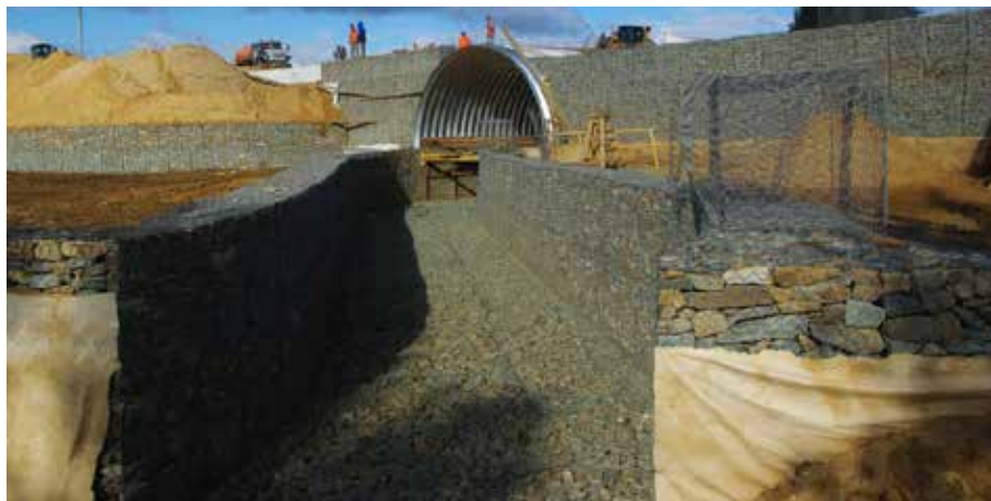
Процесс возведения мостового перехода через р. Ликова
