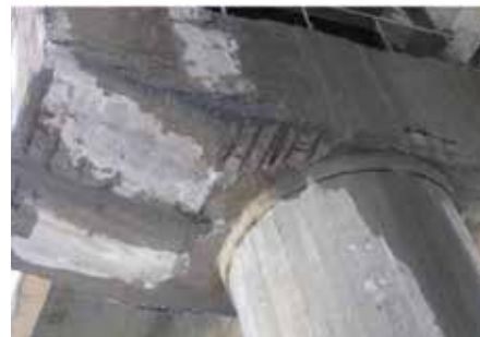
Рис. 2. Разрушение подферменника и опорной части (слева) и защитного слоя ригеля опоры (справа) вследствие систематического увлажнения через негерметичный деформационный шов
