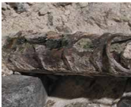
Рис. 1. Коррозия арматуры в месте разрушения защитного слоя
