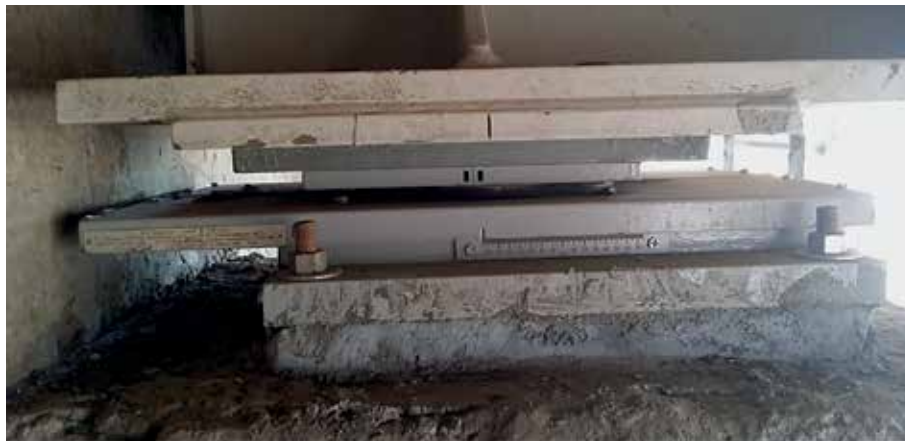
Рис. 2. Перемещение верхнего балансира опорной части на устой в крайнее положение (+76 мм)
