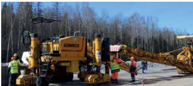
Устройство разделительного ограждения на автомагистрали М11 (Москва – Санкт-Петербург). Работа комплекса в составе: перегружатель RTP500, бетоноукладчик Commander III
