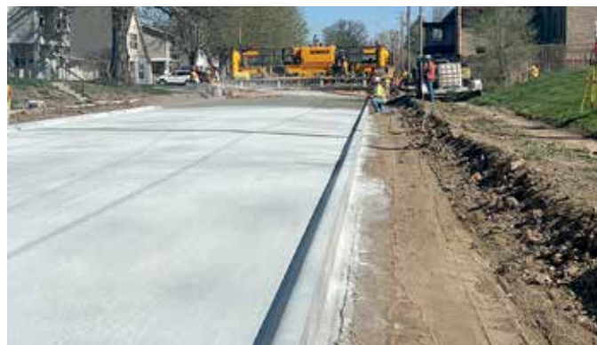
Нанесение пленкообразующего на уложенное покрытие городской улицы (после прохода бетоноукладчика с одновременным формованием бордюров с обеих сторон дороги)
