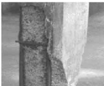
Рис.. 4. Повреждения железобетонных элементов в морской воде
