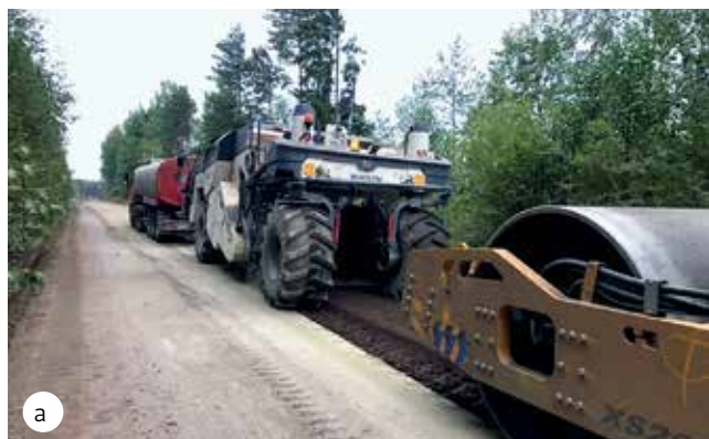
Рис. 1. Методы технологии холодного ресайклинга: а – холодный ресайклинг на месте (ХРМ); б – холодный ресайклинг с применением стационарных смесительных установок (ХРУ) [6]
