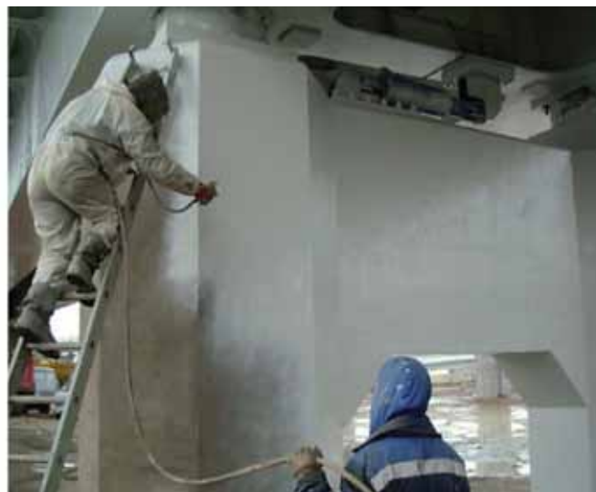
Окраска металлоконструкций железнодорожного моста. Окраска железобетонных конструкций 0+00
