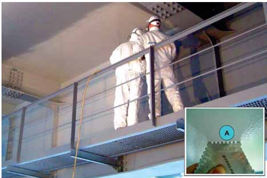
Процесс окрашивания блока с нанесенным эталонным участком материалом Stelpant-PU-Mica UV RAL 7038, регламентной толщиной. Метод окрашивания – безвоздушное распыление окрасочным агрегатом WAGNER HC 960.A – контроль толщины мокрого слоя краски калиброванным толщиномером «гребенка». Показатели толщины – 150–175 мкм
