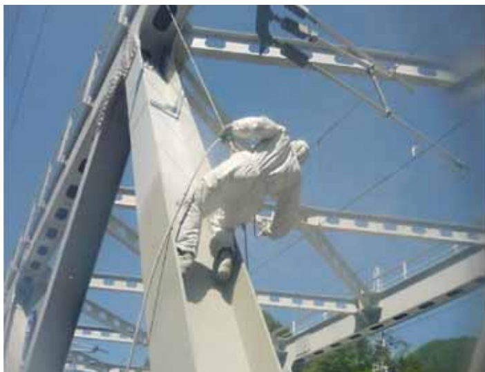
Окраска металлоконструкций железнодорожного моста. Окраска железобетонных конструкций 0+00
