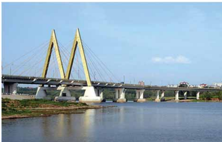
Мост «Миллениум» через реку Казанку (Казань). Комплексная защита металлоконструкций пролетных строений и железобетонных опор с покрытием Stelpant
