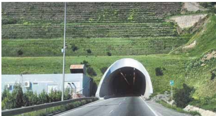
Армогрунтовое сооружение на основе системы «Зеленый Террамеш» (Грузия)
