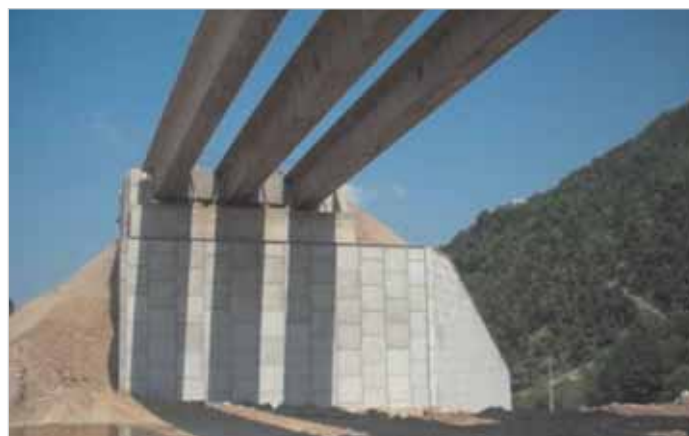
Пример подпорной стены, созданной с использованием системы «МакРес»
