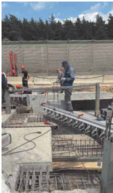
Рис. 1. Общий вид деформационного шва на объекте автомобильной дороги М-4 «Дон» Москва – Воронеж – Ростов-на-Дону – Краснодар – Новороссийск
