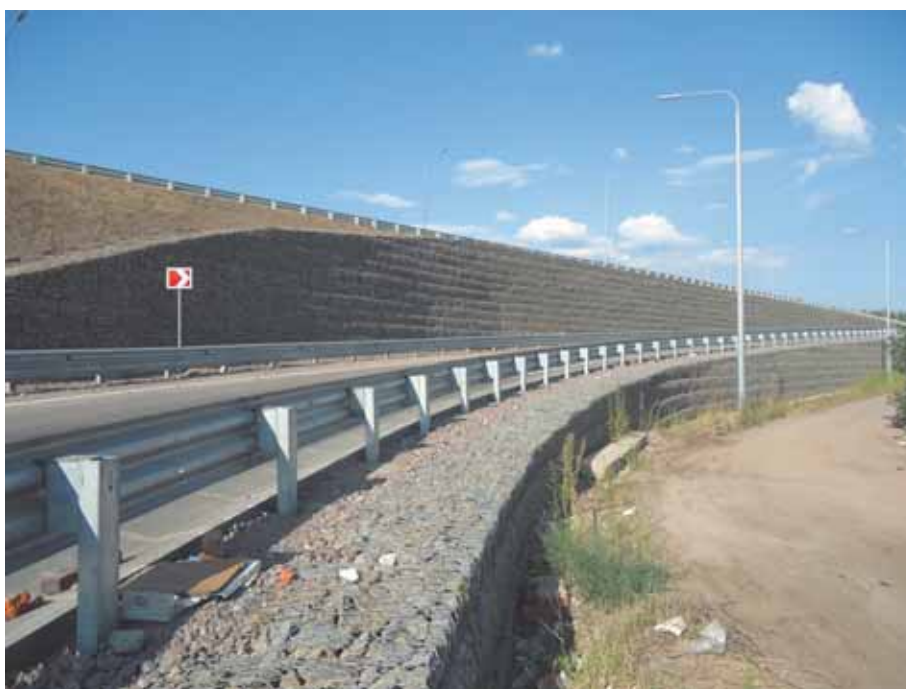
Армогрунтовое сооружение каскадного типа на основе системы «Террамеш» на обходе Воронежа (507 км трассы М4 «Дон»)
