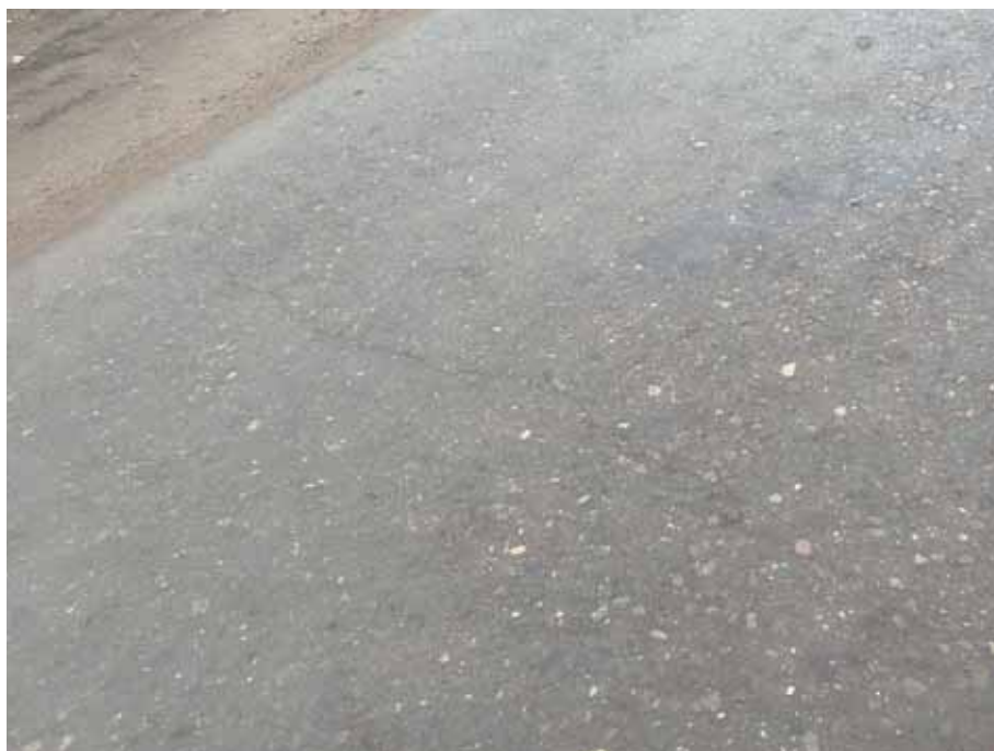
Фото 4. Пример отраженной трещины на основании, выполненном по технологии ОМС по ГОСТ 70197.1-2022, спустя месяц после укладки слоя
