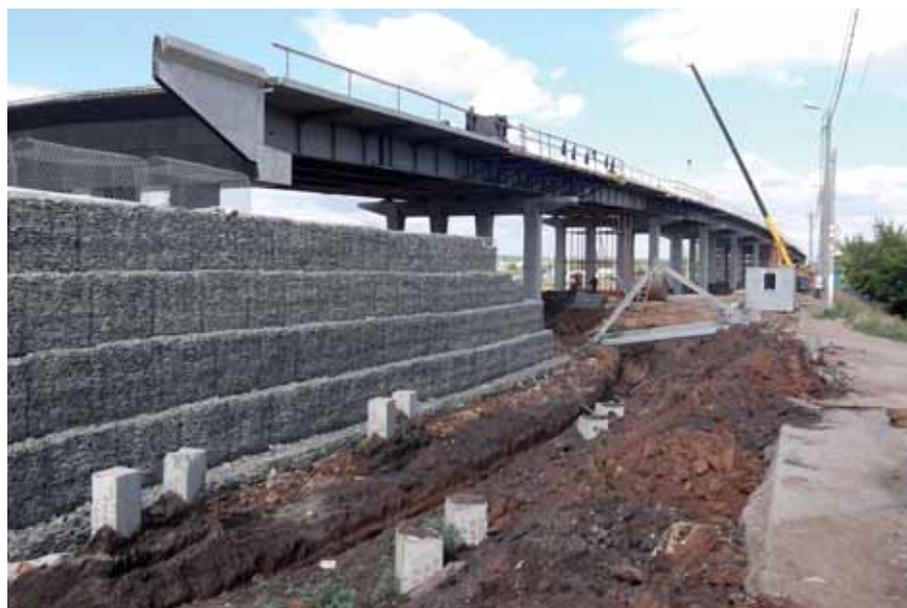
Устройство подходов к мосту с использованием армогрунтовой системы «Террамеш»
