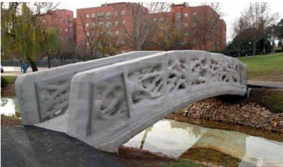
Рис. 5. Бетонный пешеходный мост пролетом 12 м, напечатанный на 3D-принтере и установленный в парке в центре Мадрида (<https://3dprint.com/307898/layer-by-layer-10-3d-printing-architectural-feats-of-originality/amp/>)
