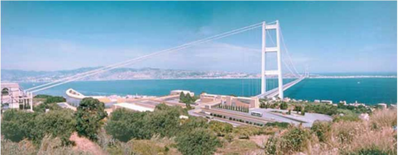
Рис. 4. Визуализация уникального моста через Мессинский пролив с рекордным пролетом 3300 м, планируемого к строительству ([https://en.wikipedia.org/wiki/Strait\\_of\\_Messina\\_Bridge](https://en.wikipedia.org/wiki/Strait_of_Messina_Bridge))
