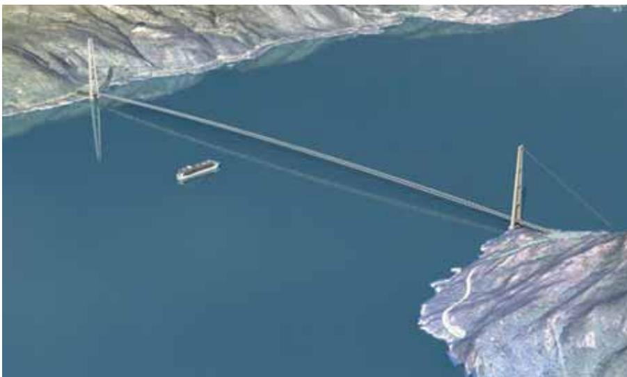
Рис. 2. Вариант висячего моста пролетом 3700 м (проект The E39 Coastal Highway Route, Норвегия, <https://www.weforum.org/stories/2016/07/norway-could-build-the-worlds-first-floating-tunnel/>)
