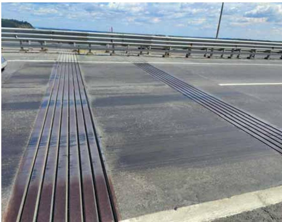
частей до выработки ресурса пролетного строения. А это (при неаккуратном поддомкрачивании) может привести к повреждению и пролетного строения, и деформационных швов. Поэтому еще при проектировании опор на них необходимо предусматривать специальные площадки под размещение домкратов.
