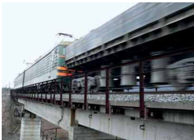
Рис. 2. Пропуск железнодорожной и автомобильной нагрузок по сооружениям промышленного предприятия. Состав с думпками в загрузочном состоянии с давлением на ось 260 кН
