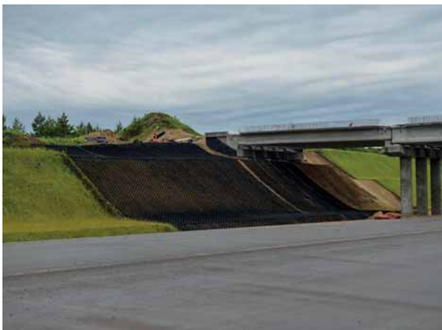
Рис. 3. Применение объемной георешетки «ГЕОСТЕП» для укрепления откосов
