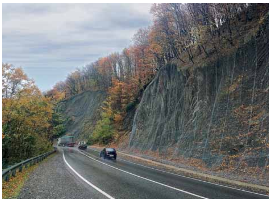
Система «Стилгريد» для защиты трассы А-147 от камнепадов
