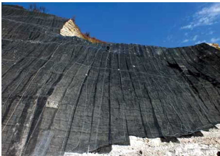
Комбинация драпировки «Стилгريد HR» и противозерозионного геомата «МакМат»
