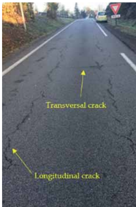
Рис. 2. Усталостные трещины при механизме образования сверху-вниз
