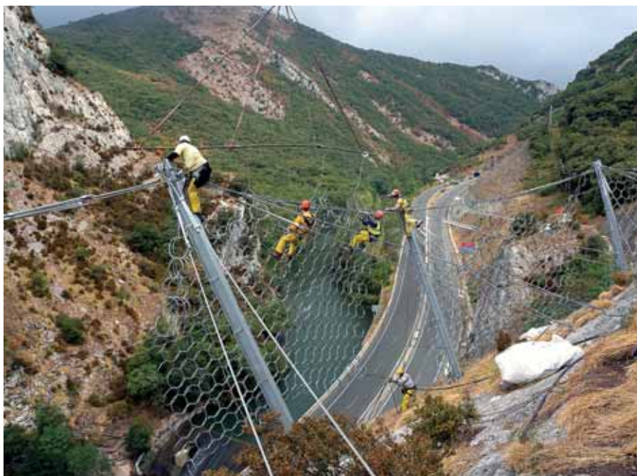
Процесс установки противокампнепадных динамических барьеров
