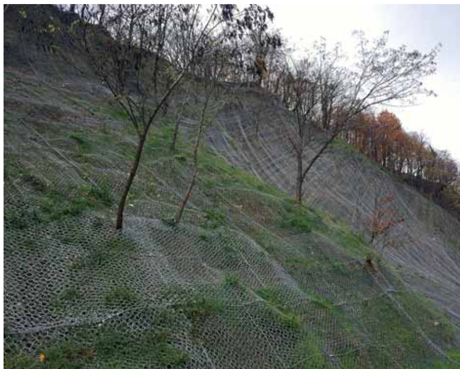
Пример монтажа «Стилгрид» без вырубki деревьев на склоне
