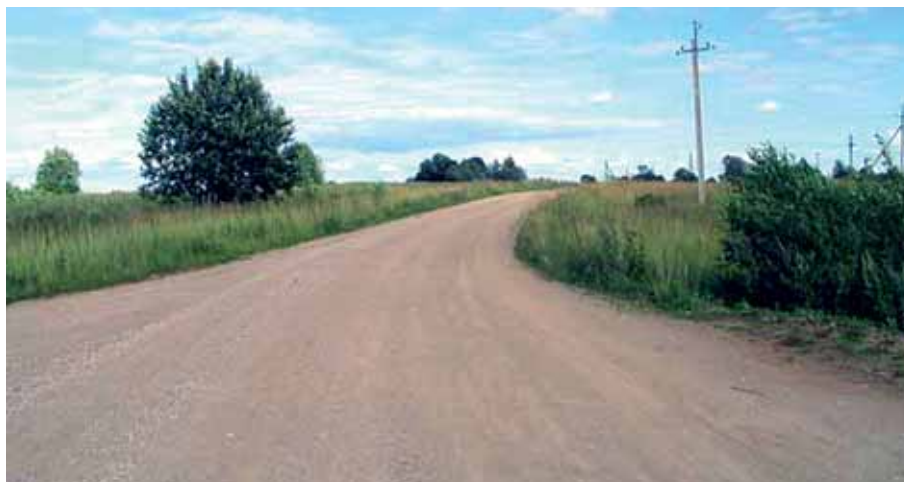
Рис. 2. Автомобильная дорога с НИД с переходным типом покрытия
