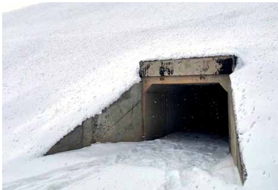
Рис. 5. Входной оголовок водопропускной трубы. Высота отверстия трубы над уровнем льда – 1,35 м
