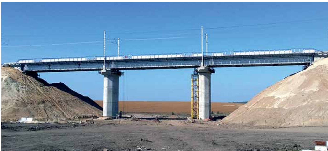
Рис. 1. Общий вид железнодорожного путепровода
