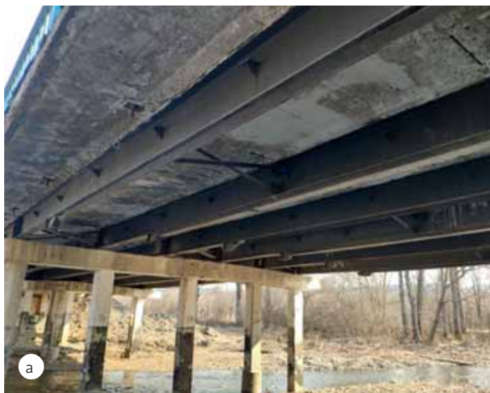
Рис. 6. Текущий вид мостовых сооружений, построенных с применением стеклокомпозитной арматуры в 1980-е годы (фотографии 2024 года):
