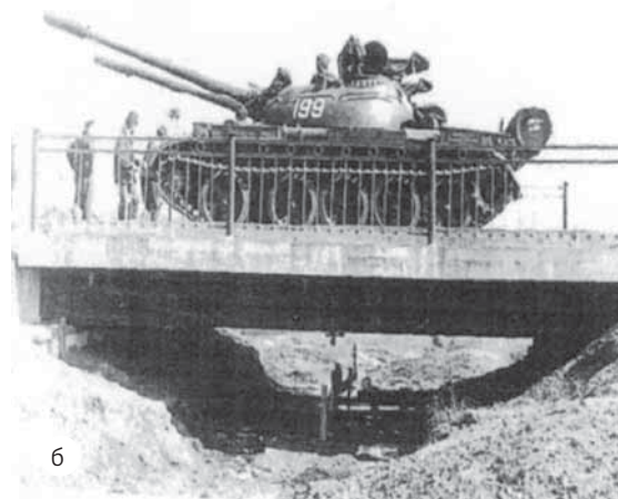
Рис. 1. Конструкция деревожелезобетонного пролетного строения с балками из клееной древесины, предварительно напряженной стеклопластиковой арматурой:
