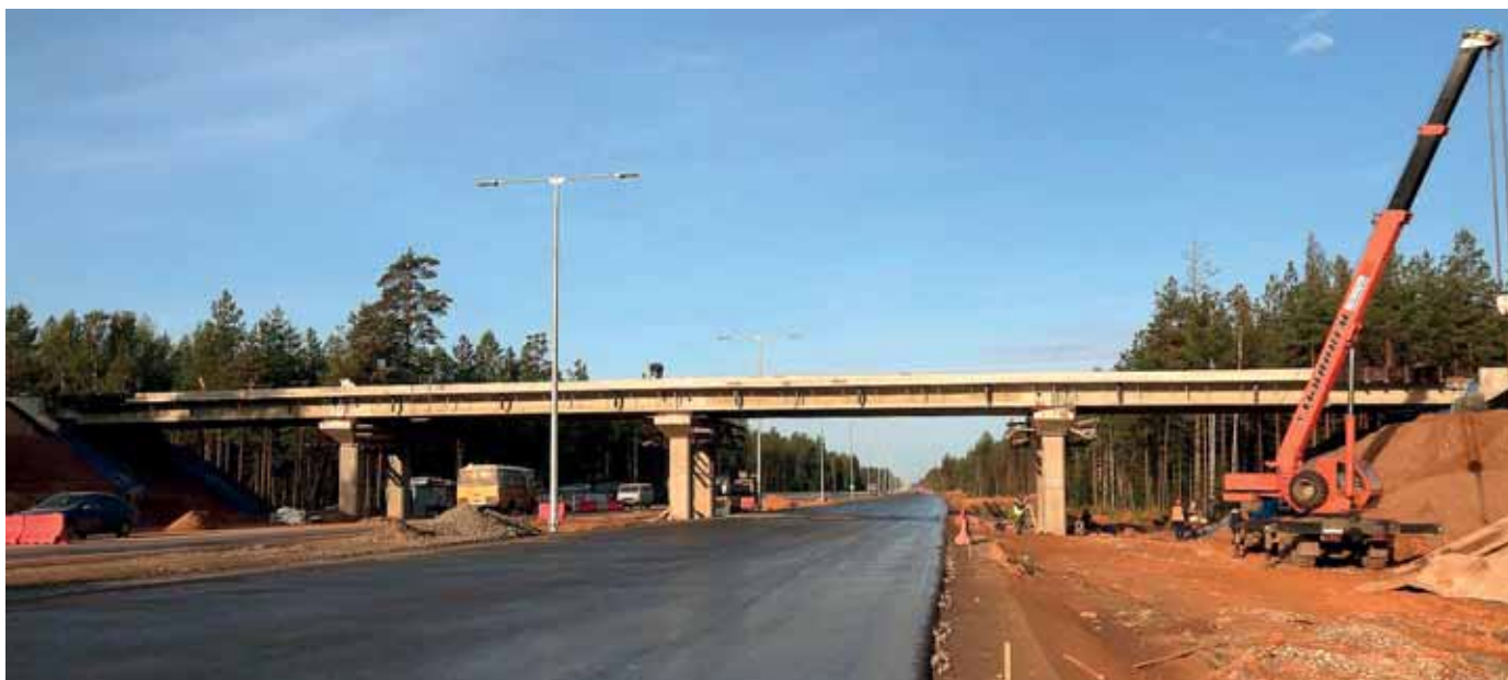
Рис. 9. Общий вид строящегося путепровода (2017 год)
