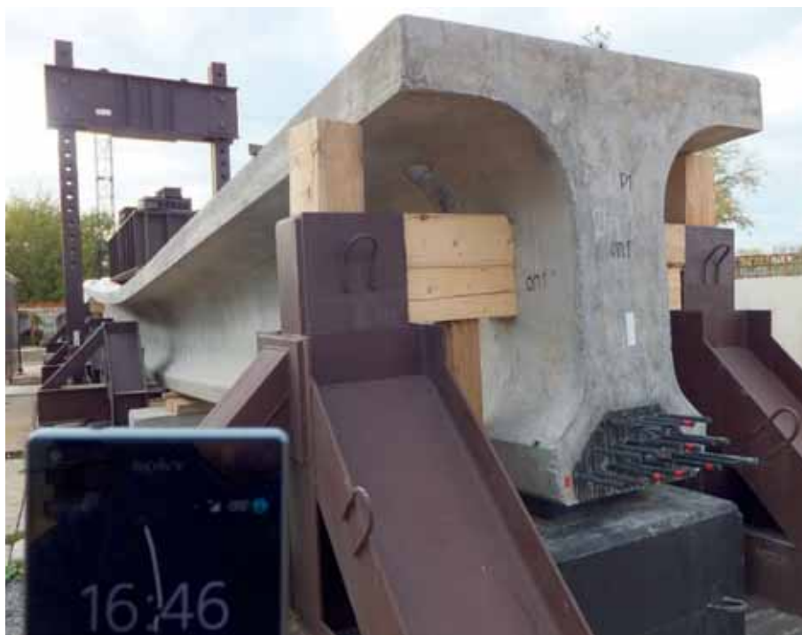
Рис. 8. Опытная балка на стенде после разрушения
