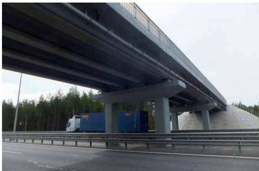
Рис. 10. Общий вид эксплуатируемого путепровода (2019 год)
