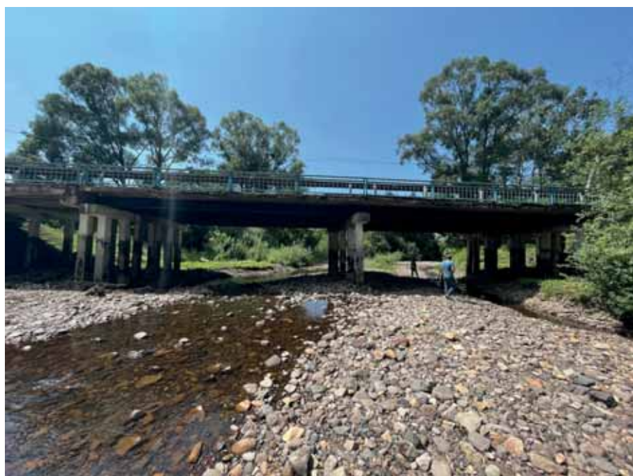
Рис. 5. Общий вид моста через реку Тигровую в Приморском крае
