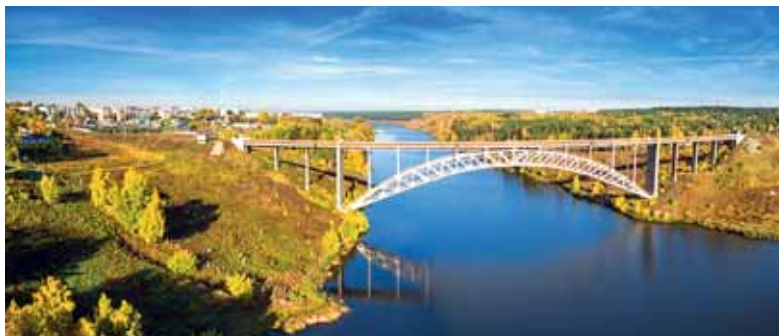
Рис. 3. Первый в России и второй в мире мост из трубобетона, железнодорожный арочный мост через реку Исеть с пролетом более 100 м, построенный в 1940 году и эксплуатируемый до настоящего времени
