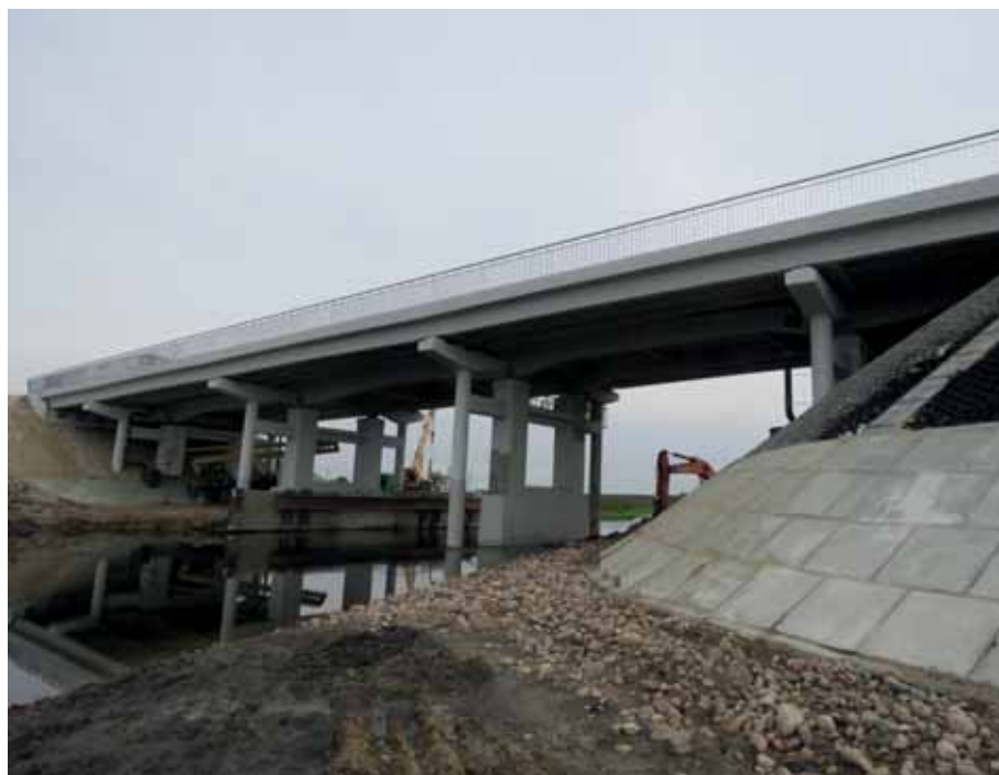
Рис. 4. Мост через реку Гривду на автодороге Р-2 Столбцы – Ивацевичи – Кобрин
