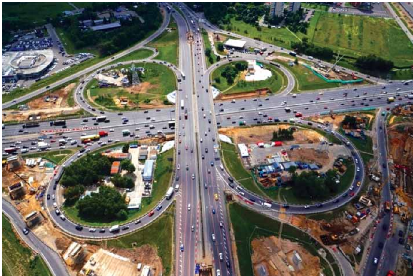
Рис. 3. Отсутствие на прямом направлении автомагистрали полос перестроения для въезда на прямое направление автомагистрали и съезда с него. Частично связанное состояние транспортного потока по сквозному направлению и плотное на подъезде к левому нижнему кольцевому съезду
