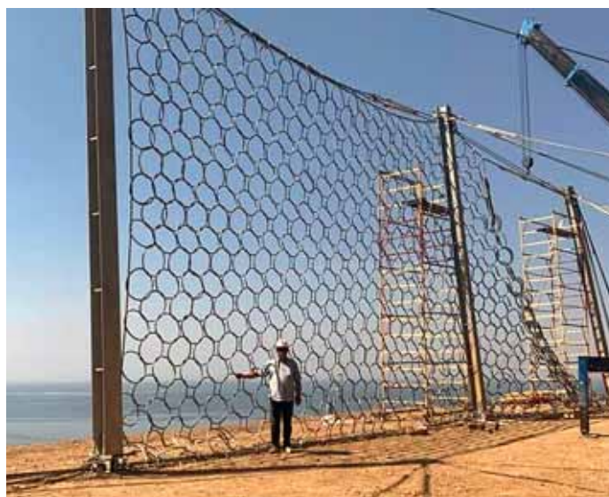
А.М. Назаров на строительной площадке: идет установка камнеулавливающих барьеров RMC
