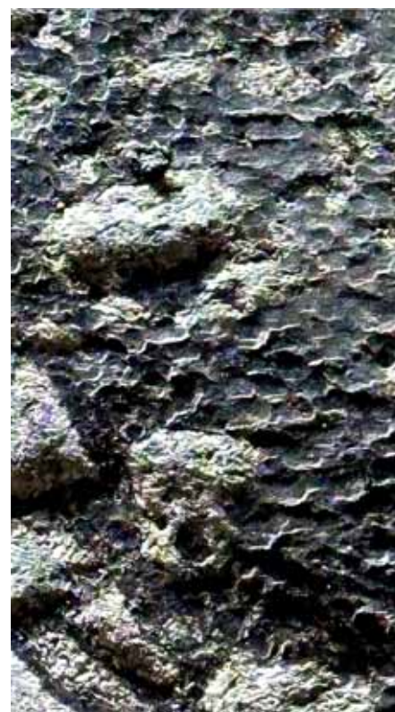
Рис. 2. Результат воздействия шипованных шин на дорожное покрытие (ЩМА 16)
