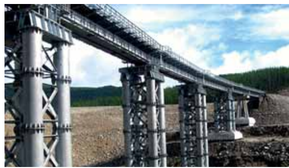
Рис. 4. Практическое применение трубобетона в опорах железнодорожных мостов на дороге Улак – Эльга, 2012 год
