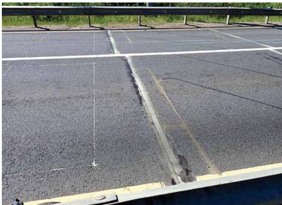
Рис. 2. Весоизмерительные устройства на проезжей части автомобильной дороги (лето 2024 г.).
