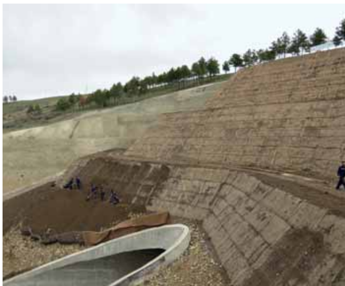
Строительство Горского тоннеля, Грузия. Система «Зеленый Террамеш»
