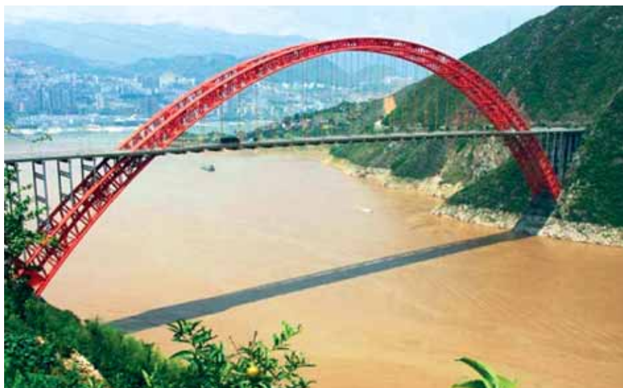
Рис. 7. Уникальный арочный мост из трубобетона, построенный в Китае с пролетом 460 м
