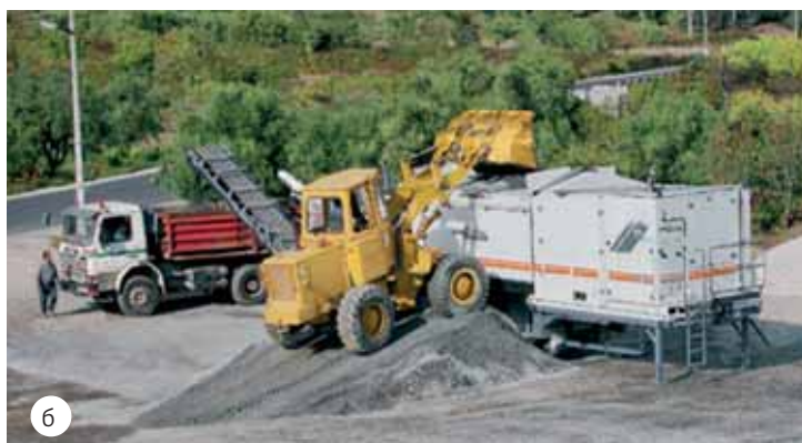
Рис. 1. Методы технологии холодного ресайклинга: а – холодный ресайклинг на месте (ХРМ); б – холодный ресайклинг с применением стационарных смесительных установок (ХРУ) [6]
