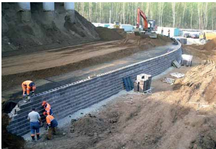
Процесс возведения армогрунтовой системы «МакВолл»
