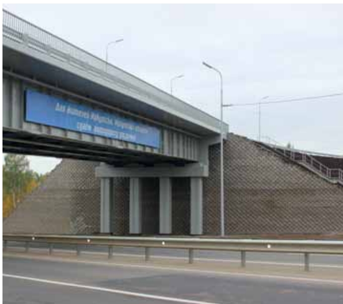
Устройство конусов моста с применением армогрунтовой системы «МакВолл»
