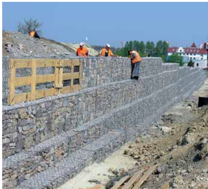
Процесс монтажа армогрунтовой системы «Террамеш»
