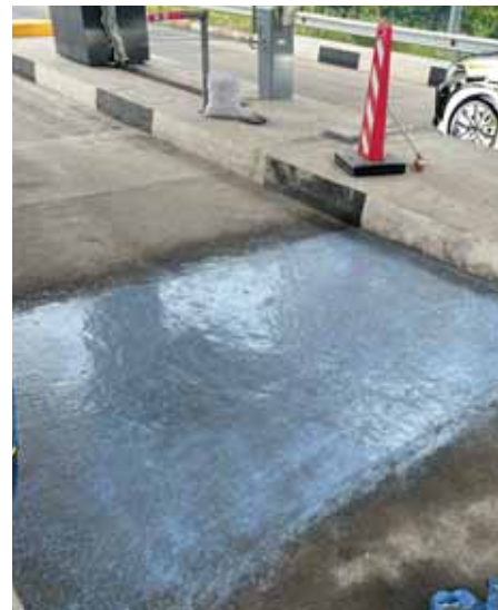
Применение СПФБ ЦЕМЕНТАЛЬ® в качестве добавленного слоя на участке торможения и разгона пункта взимания платы
