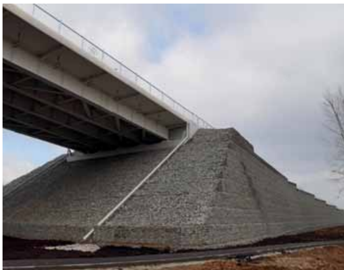
Система «Террамеш» и матрацы Рено для укрепления конусов моста
