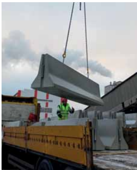
Завод ЖБИ ЦЕМЕНТУМ в Коломне: отгрузка блоков парапетного ограждения «Нью-Джерси»
