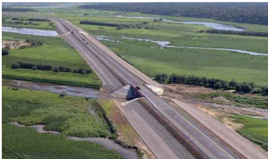
Матрацы Рено – защита подтопляемых откосов автодороги
