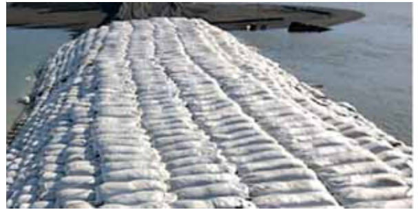
Рис. 4. Дамба, сооруженная с применением геоконтейнеров ГЕОБЭГ
