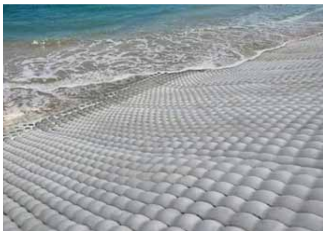
Рис. 6. Цементирующая геооболочка БЕТОБОКС на укрепляемом склоне (берег Балтийского моря)
