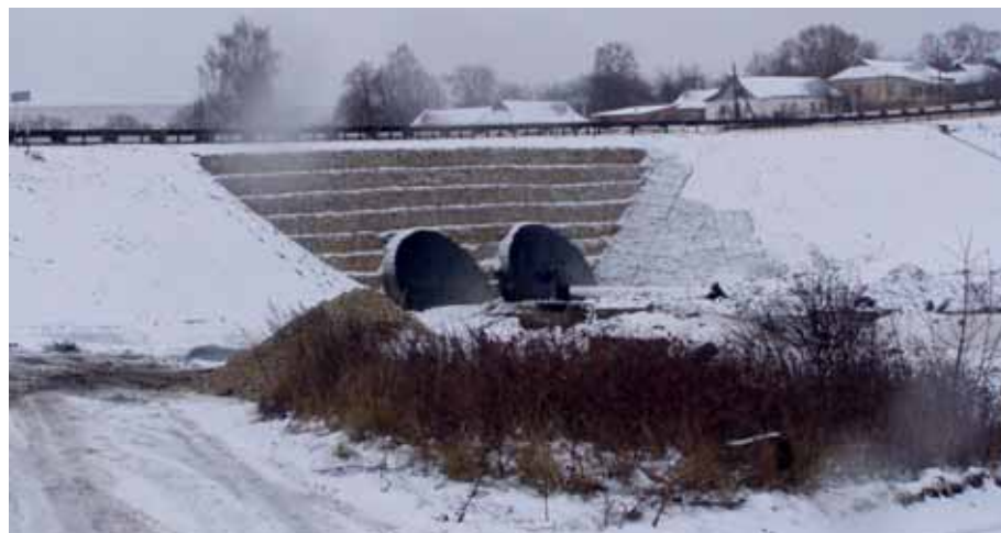
Рис. 10. Двухочковая труба на дороге Лопотково – Ефремов
