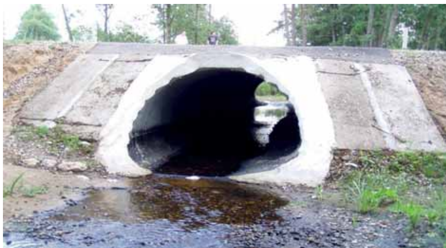
Рис. 4. Труба с пониженным профилем на автомобильной дороге в Калужской области
