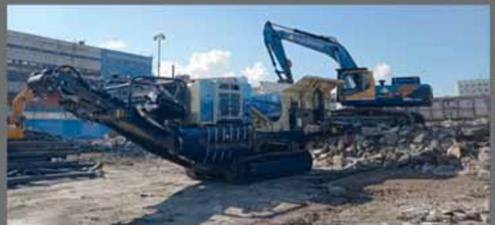
Северо-Запад. Гусеничная дробильно-сортировочная установка для переработки бетонных и железобетонных отходов
