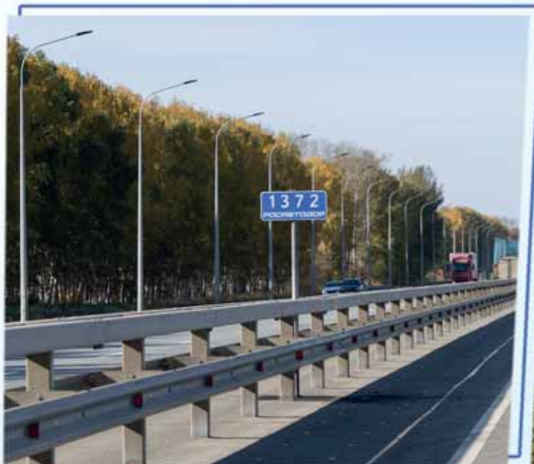
Барьерные ограждения для безопасного движения транспорта и пешеходов
