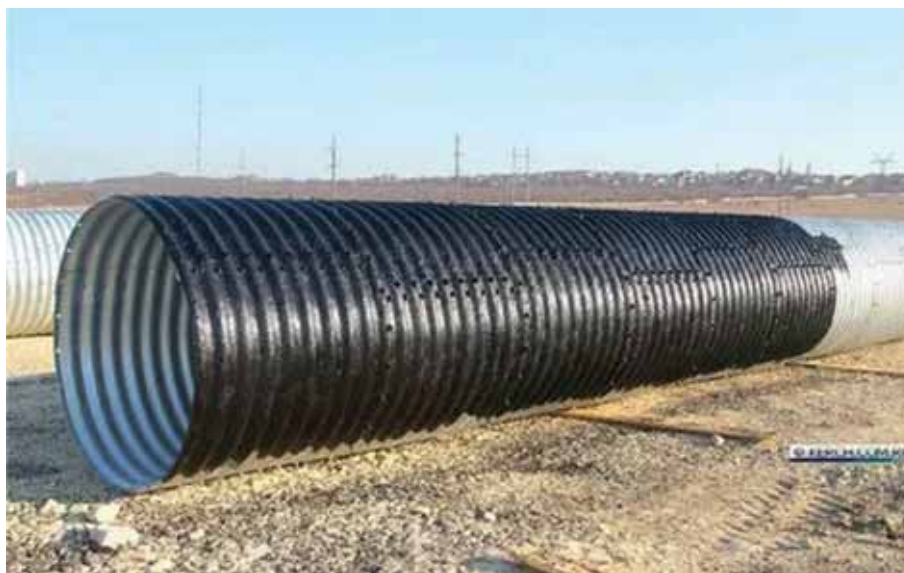
Рис. 1. Собранная гофрированная оболочка защищается от коррозии дополнительным водостойким покрытием (источник: kerch.bezformata.com)
