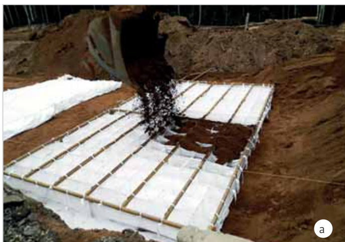
Рис. 2. Геоболочка ГеоФРАМ: а) стандартная геоболочка ГеоФРАМ на каркасе; б) геоболочка ГеоФРАМ, имеющая полог
