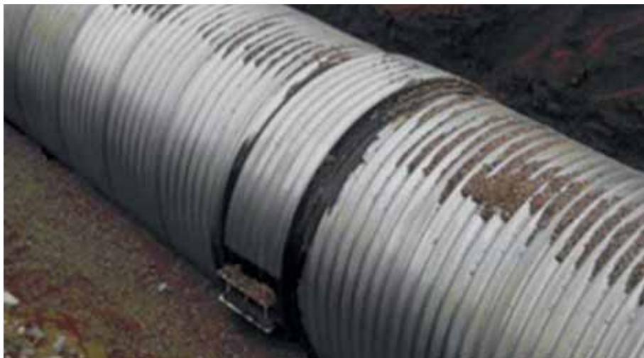
Рис. 3. Стык секций цельновитой трубы (источник: russian.alibaba.com)
