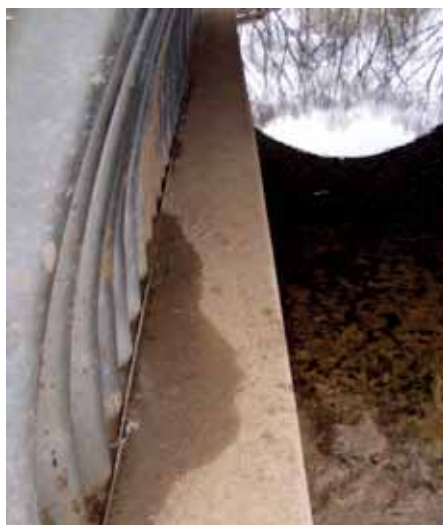
Рис. 9. Фильтрация воды в пятах и стыках свода
