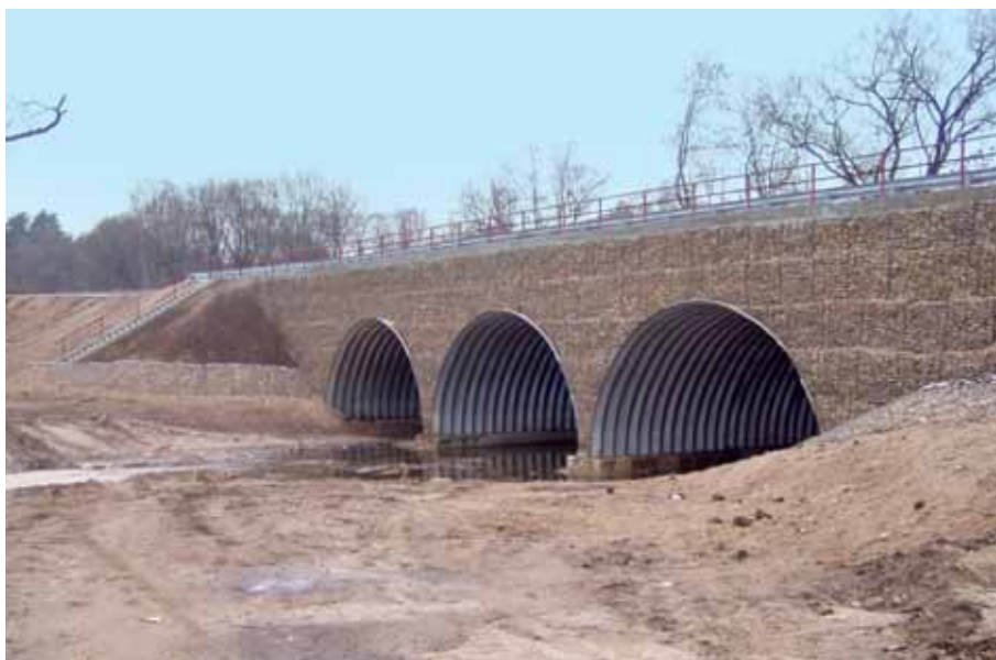
Рис. 6. Арочный мост через реку Дубровинку
