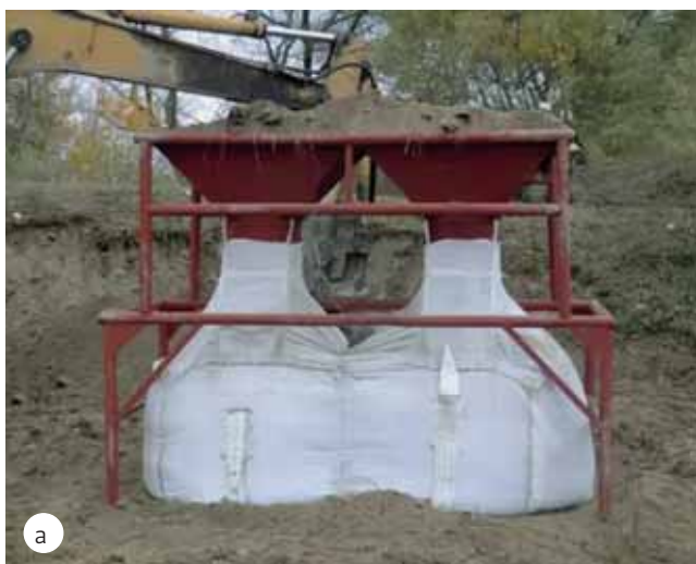
Рис. 5. Геоконтейнер ГЕОБЭГ: а) засыпка геоконтейнера при помощи загрузочного бункера; б) погрузка геоконтейнера
