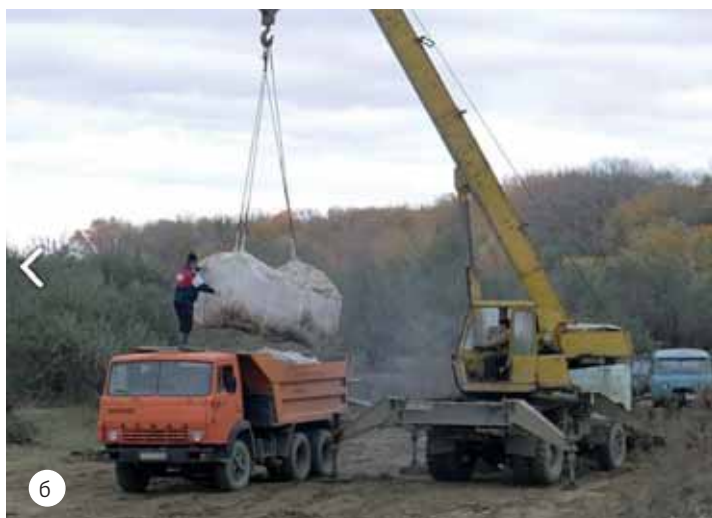
Рис. 5. Геоконтейнер ГЕОБЭГ: а) засыпка геоконтейнера при помощи загрузочного бункера; б) погрузка геоконтейнера
