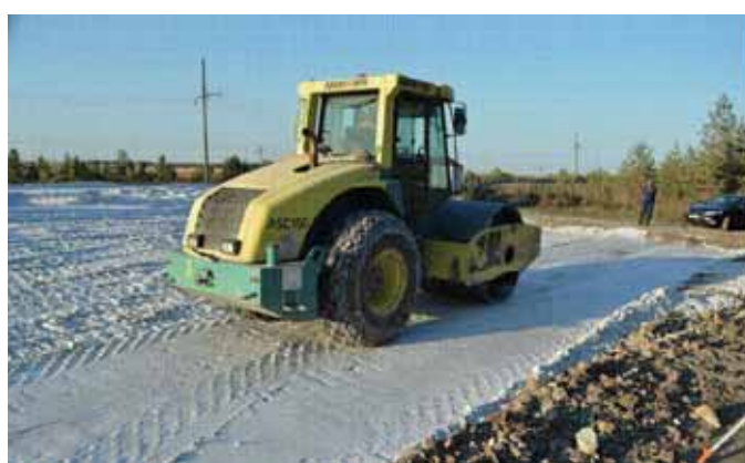
Рис. 6. Уплотнение виброкатком
