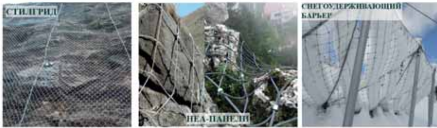
Рис. 4. Примеры конструкций и сетчатых материалов для статических нагрузок
