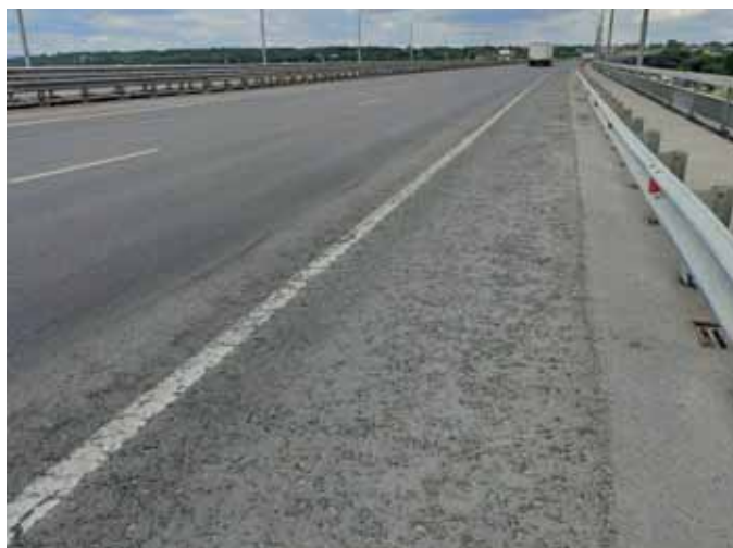
Рис. 2. Дорожная одежда на мосту через Волгу по направлению к Саратову
