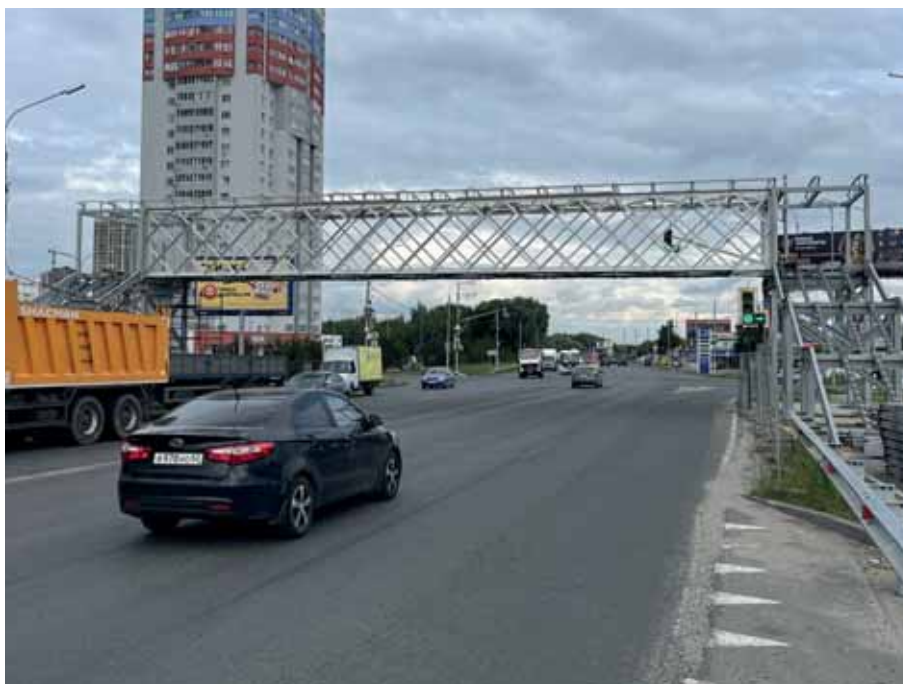
Монтаж пролетного строения пешеходного перехода в Рязани
