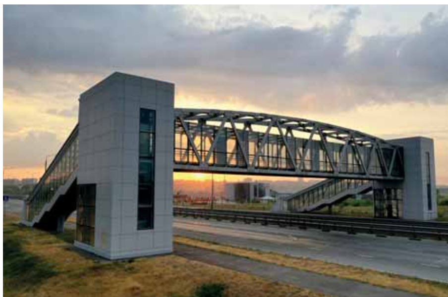
Пешеходный мост в Туле. Первый мост из алюминиевых сплавов в ЦФО
