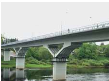
Фото 6. Открытие моста после реконструкции
