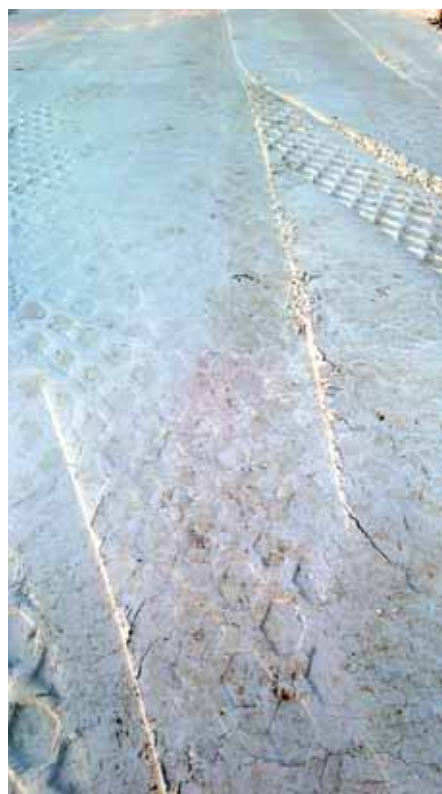
Рис. 7. Результат уплотнения слоя
