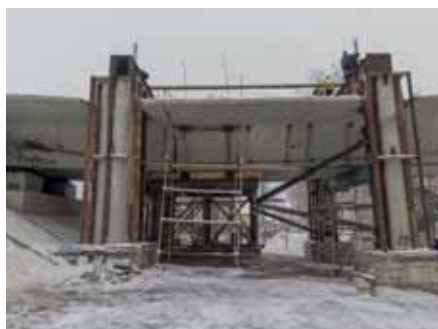
Фото 3. Установка специальных временных опор для подъёмки
