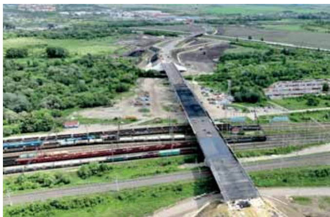
Рис. 1. Транспортная развязка на ул. 40 лет Октября (завершение строительства) (источник: penza-post.ru )
