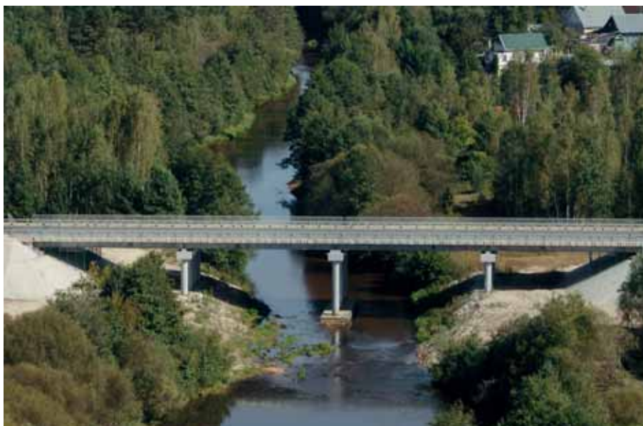
Первый в РФ автодорожный мост из алюминиевых сплавов в Нижегородской области
