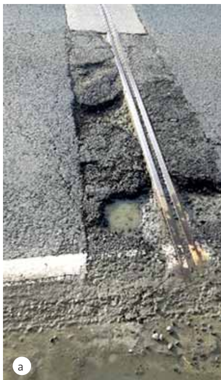
Рис. 15. Дефекты деформационного шва
