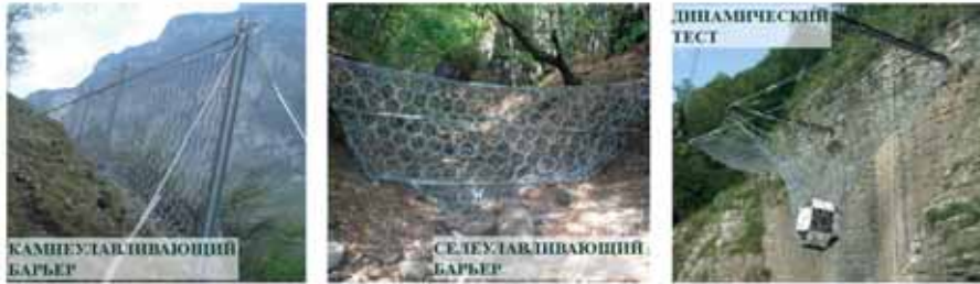
Рис. 5. Примеры конструкций и материалов для динамических нагрузок
