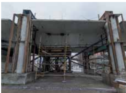
Фото 5. Общий вид пролетного строения после подъёмки
