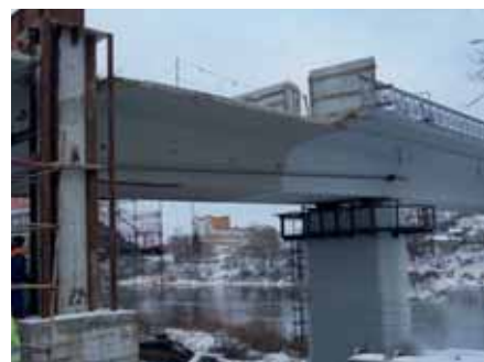
Фото 4. Усиление пролетного строения перед подъёмкой
