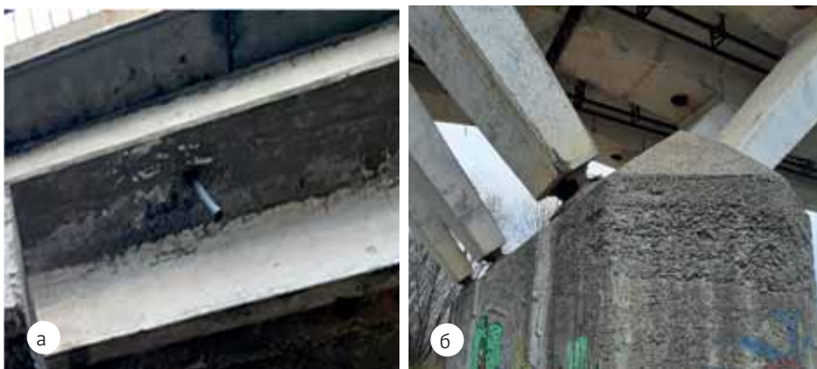
Рис. 7. Выщелачивание бетона: а) близ водоотводной трубки; б) на поверхности бетона массивной опоры (быка), автодорожный мост, г. Пенза
