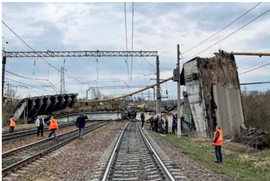
Рис. 2. Обрушение моста в Вязьме
