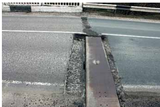
Рис. 17. Деформационный шов на опоре 6
