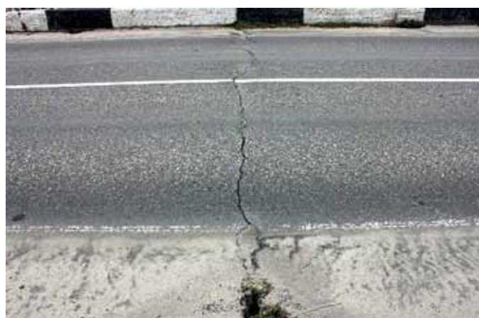
Рис. 16. Деформационный шов на опоре 3
