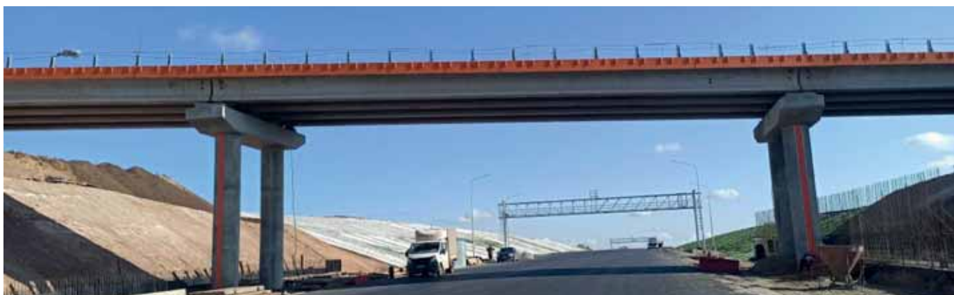
Путепровод с покрашенными карнизными блоками из СПФБ
