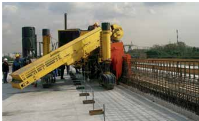
Укладка барьерного ограждения поверх армокаркаса с применением универсального бетоноукладчика Commander III на участках пролетных строений транспортного пересечения МКАД с магистралью Вешняки – Люберцы.
