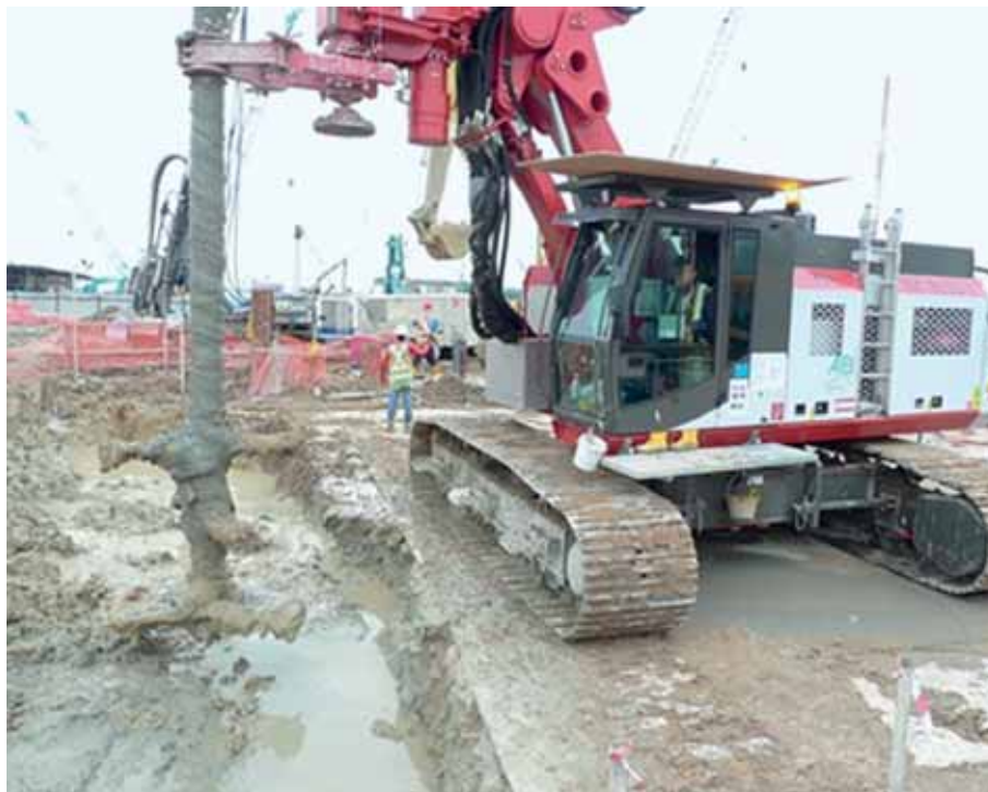
Рис. 2. Установка ABI для глубинного смешивания грунта с вяжущими
