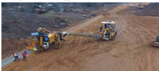
Устройство кювета (водоотводной канавы) на участке автомагистрали М1 «Беларусь» с применением бетоноукладчика Commander III, RTP500 GOMACO.
