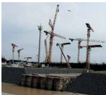
Рис. 6. Основание, устроенное методом глубинного укрепления грунта
