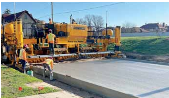
Применение системы 3D-нивелирования при строительстве дороги в черте города. Бетоноукладчик GP3 на укладке покрытия городской улицы – 9 м за проход, с одновременным формованием бордюров с обеих сторон проезжей части
